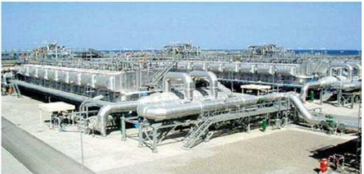
Εικόνα 1.8: Εγκατάσταση πολυβάθμιας εκτόνωσης στη Μέση Ανατολή [20]
