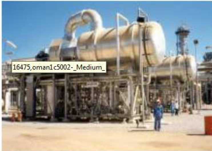
Εικόνα 1.9: Εγκατάσταση εξάτμισης με επανασυμπύεση ατμών [14]
