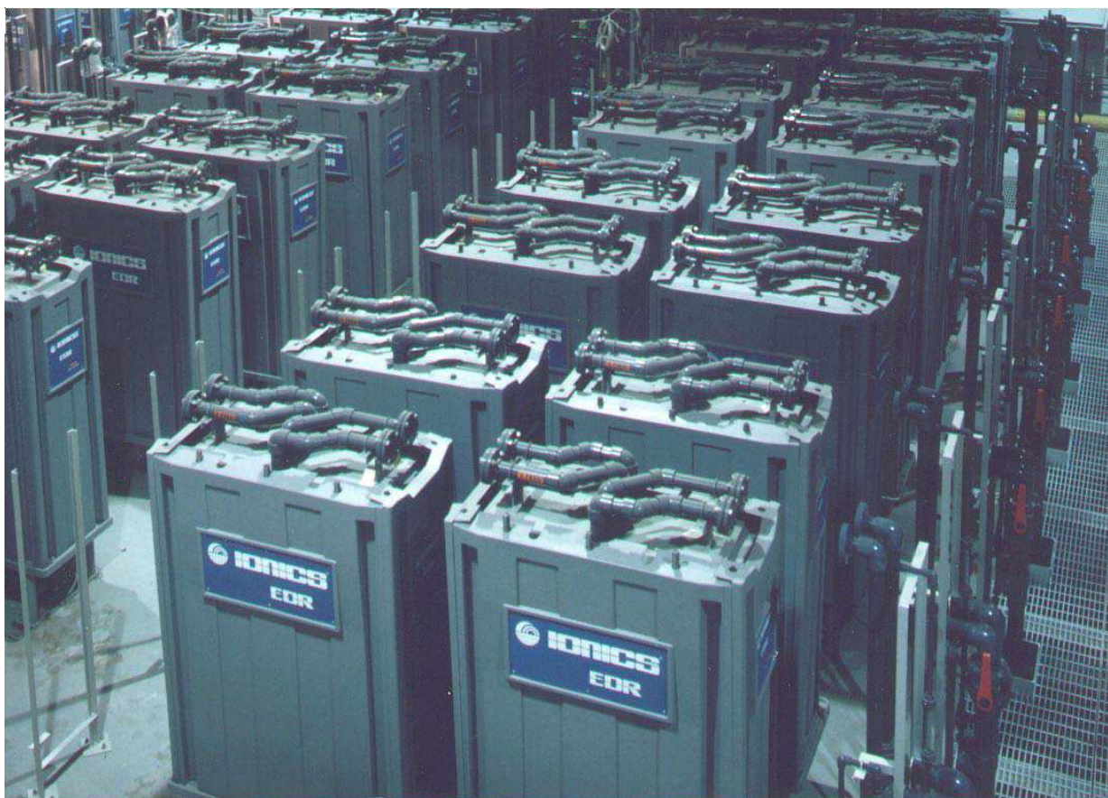
Εικόνα 1.12: Εγκατάσταση ηλεκτροδιάλυσης [6]
