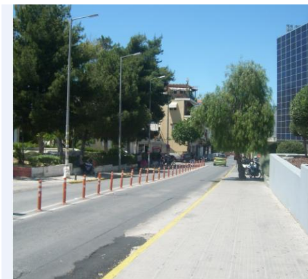
Εικόνα 5.17- Υφιστάμενη κατάσταση σε οδό Ελευθερίου Βενιζέλου σε Δήμο Α.Δημητρίου
