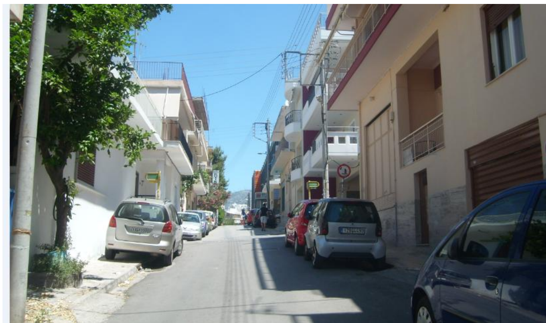
Εικόνα 5.16-Υφιστάμενη κατάσταση οδού Γρηγορίου Λαμπράκη σε Δήμο Α.Δημητρίου
