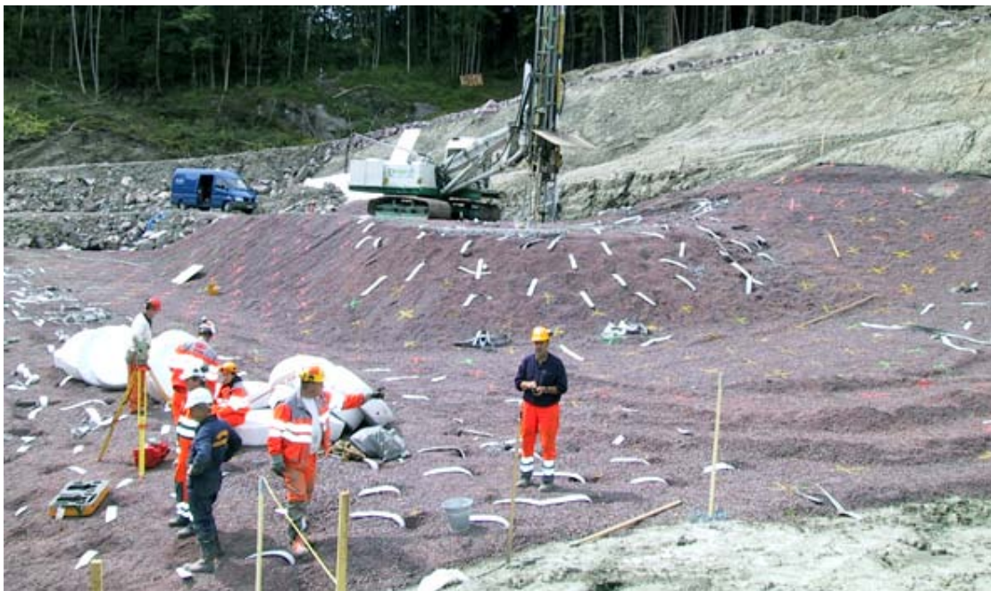
ΕΙΚΟΝΑ 1.2 ΕΝΙΣΧΥΣΗ ΑΡΓΙΛΙΚΟΥ ΣΤΡΩΜΑΤΟΣ ΜΕ ΠΡΟΦΟΡΤΙΣΗ ΚΑΙ ΧΡΗΣΗ ΚΑΤΑΚΟΡΥΦΩΝ ΣΤΡΑΓΓΙΣΤΗΡΙΩΝ ΒΑΘΟΥΣ 20-22 ΜΕΤΡΩΝ ΓΙΑ ΤΗΝ ΕΠΙΤΑΧΥΝΣΗ ΤΗΣ ΔΙΑΔΙΚΑΣΙΑΣ
