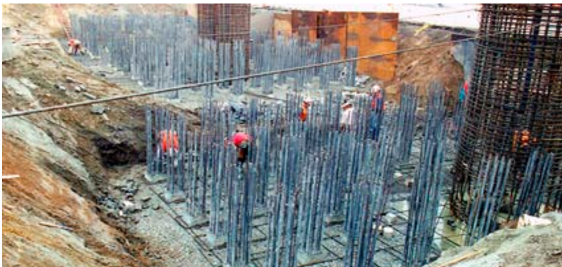
ΕΙΚΟΝΑ 1.1 ΘΕΜΕΛΙΩΣΗ ΚΑΤΑΣΚΕΥΗΣ ΜΕ ΠΕΔΙΛΑ
