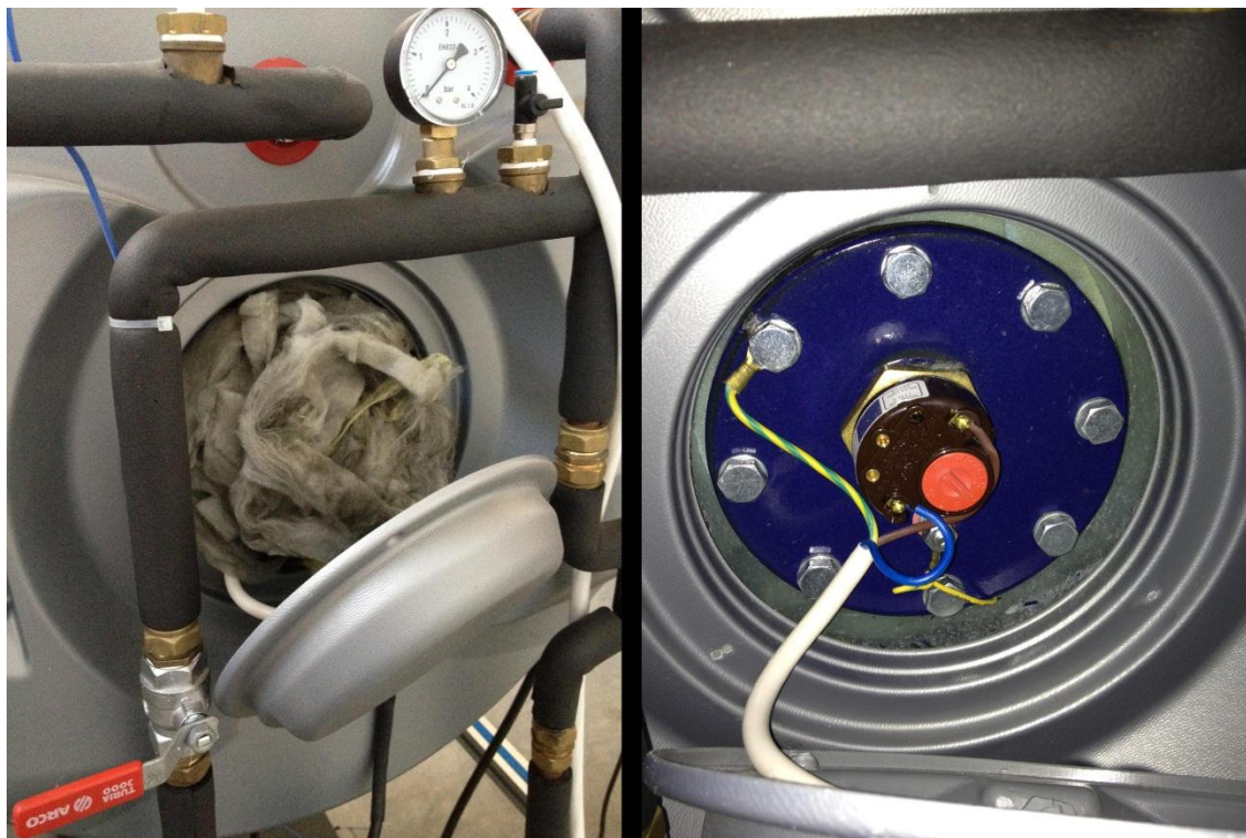
Εικόνα 3.6.1 Απομάκρυνση του υαλοβάμβακα μόνωσης και έλεγχος του boiler για διαρροές
