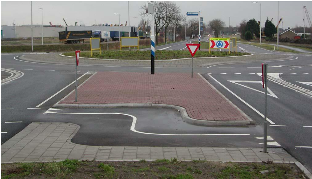
Σχήμα 2.33. Υπεραστικός κυκλικός κόμβος δύο λωρίδων με ποδηλατόδρομο (Fortuijn, 2003).
