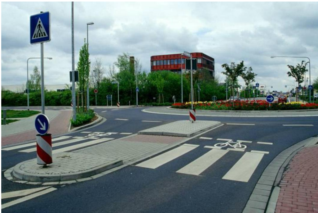
Σχήμα 3.72. Τυπική κατευθυντήρια νησίδα με διάβαση πεζών και ποδηλατόδρομο (Brilon et al., 2006).
