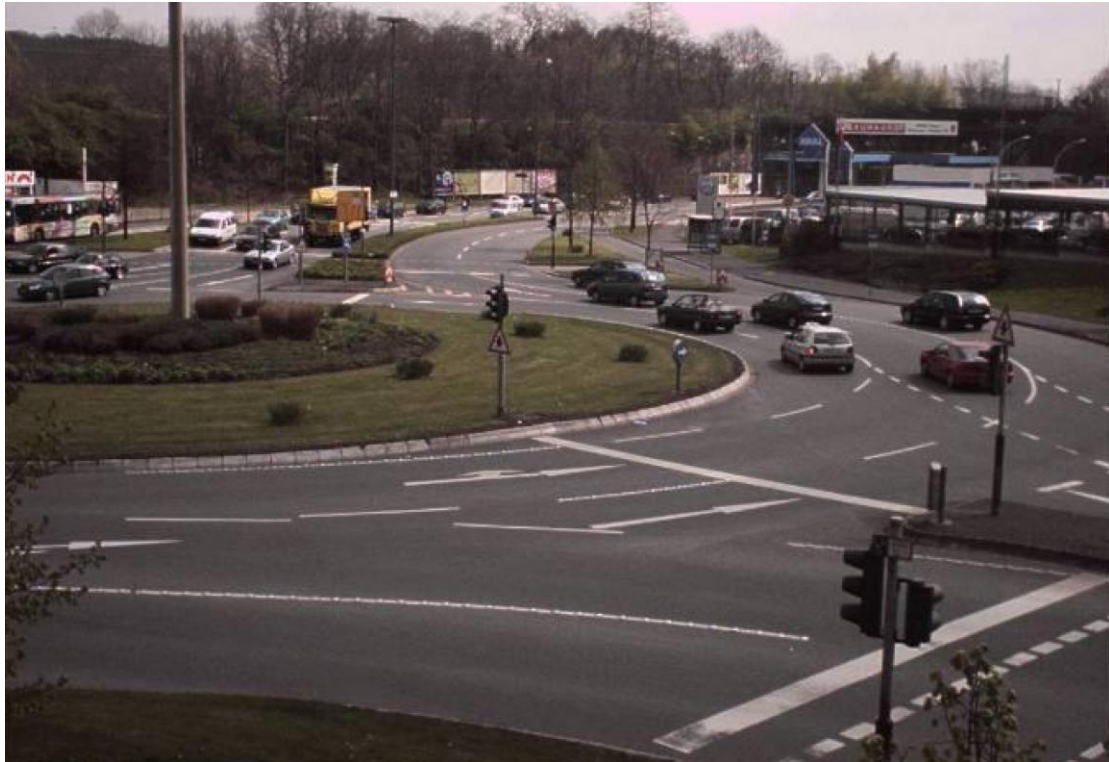
Σχήμα 3.65. Μεγάλος Κυκλικός Κόμβος με Σηματοδότηση (Grosser Kreisverkehr mit Lichtsignalanlage - LSA) (Brilon et al., 2006).
