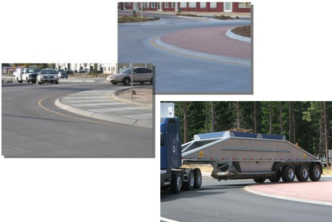
Σχήμα 2.21. Περιμετρική ζώνη, κατάλληλα διαμορφωμένη, ώστε όταν καταστεί αναγκαίο να χρησιμοποιείται από βαρέα οχήματα με σκοπό να διευκολύνεται η κίνησή τους (NCHRP & FHWA, 2010).
