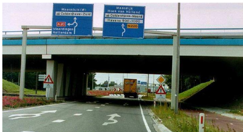
Σχήμα 2.62. Έγκαιρη και σαφής σήμανση και διαγράμμιση οδοστρώματος ώστε οι οδηγοί να επιλέγουν βάσει της επιθυμητής εξόδου (προορισμού) την κατάλληλη λωρίδα εισόδου και κυκλοφορίας στον κόμβο, αποφεύγοντας περιττούς ελιγμούς (Brilon, 2011).
