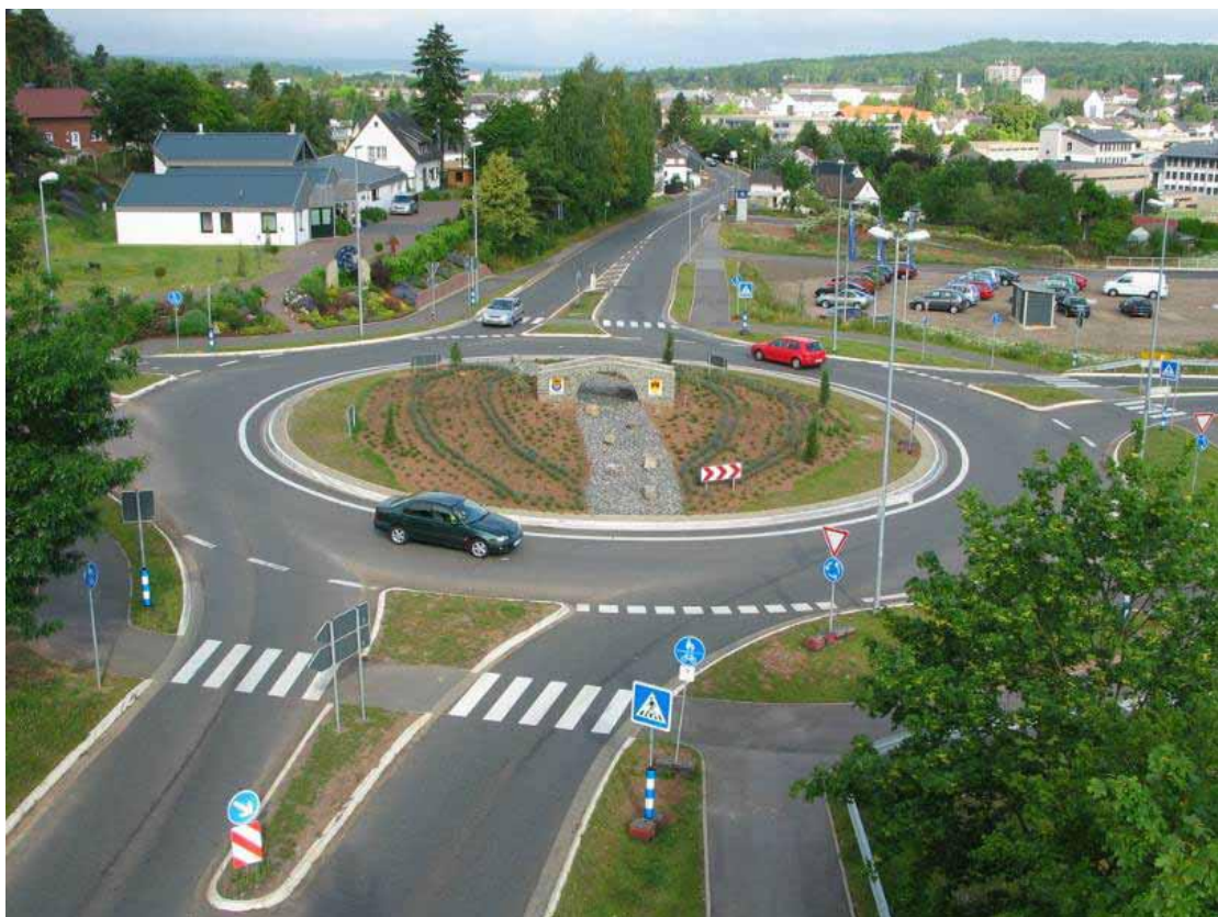
Σχήμα 2.14. Σύγχρονος Κυκλικός Κόμβος Μίας Λωρίδας (Brilon, 2011).
