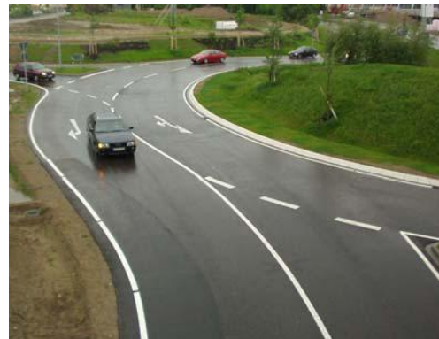
Σχήμα 2.64. Γερμανία: Τετρασκελής Σπειροειδής Κόμβος κοντά στην πόλη Baden-Baden με παρακαμπτήρια λωρίδα και γέφυρα για πεζούς και ποδηλάτες. (Διακρίνεται η απουσία υπερυψωμένων διαχωριστικών των λωρίδων) (Brilon, 2011).
