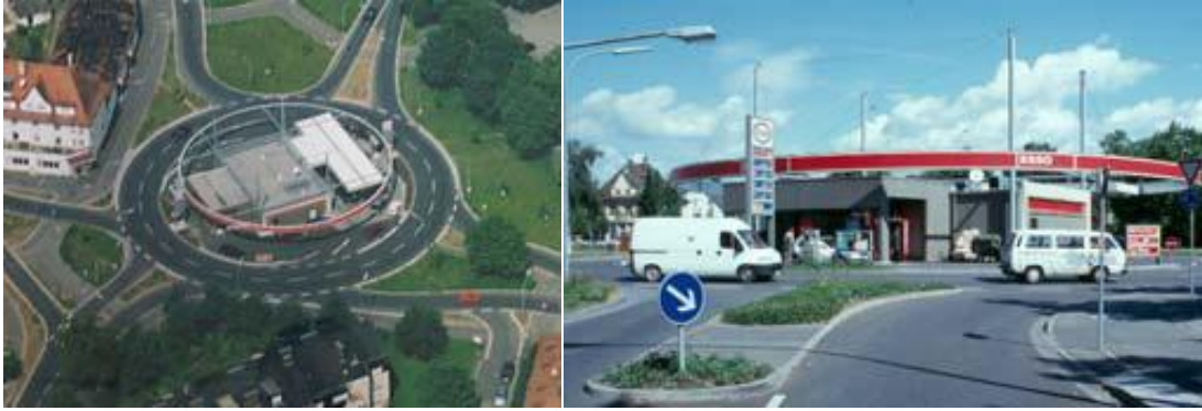
Σχήμα 2.36. Προτείνεται η αποφυγή τοποθέτησης εμποδίων επί της κεντρικής νησίδας (Εδώ: Πρατήριο υγρών καυσίμων κοντά στην πόλη Konstanz της Γερμανίας) (Brilon, 2011).
