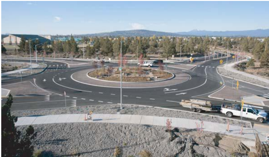
Σχήμα 2.55. Παραδείγματα κυκλικών κόμβων δύο λωρίδων στις Η.Π.Α. (NCHRP & FHWA, 2010).
