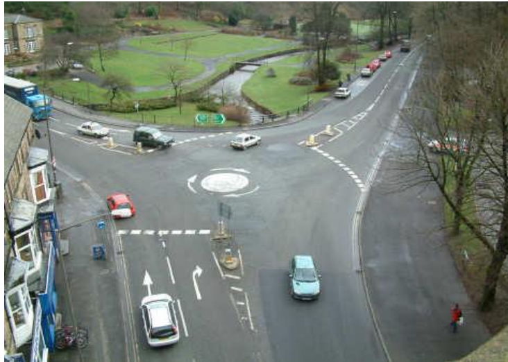
Σχήμα 2.27. Κυκλικός Κόμβος Μικρής Διαμέτρου (The Highways Agency et al., 2007).
