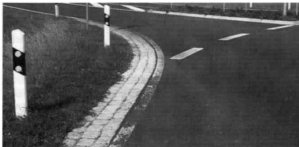
Σχήμα 3.67. Καμπύλη (τόξο) συναρμογής (στρογγύλευσης) οριογραμμής εισόδου (FGSV, 2006).
