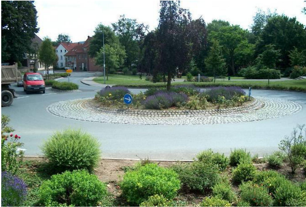
Σχήμα 3.61. Αστικός Μικρός Κυκλικός Κόμβος (Kleiner Kreisverkehr innerhalb bebauter Gebiete) (Brilon et al., 2006).
