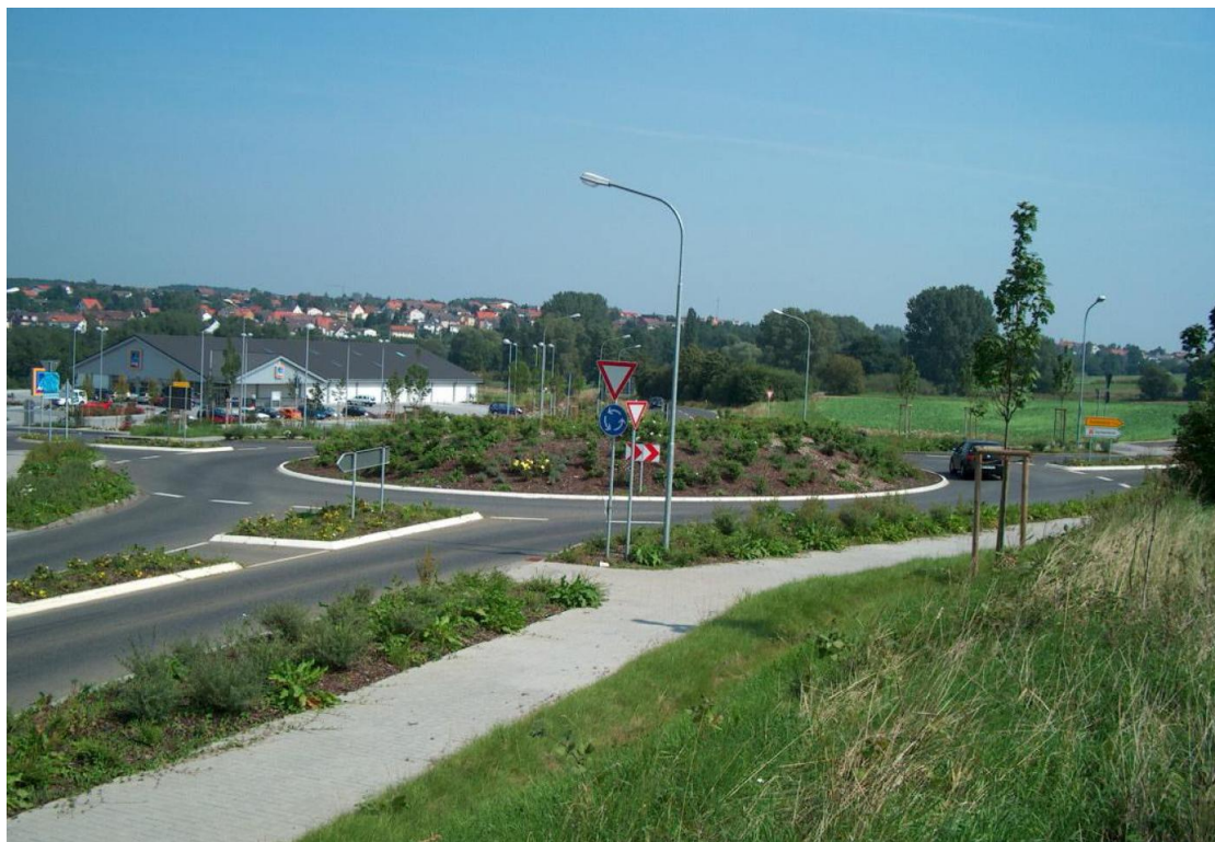
Σχήμα 3.62. Υπεραστικός Μικρός Κυκλικός Κόμβος (Kleiner Kreisverkehr ausserhalb bebauter Gebiete) (Brilon et al., 2006).
