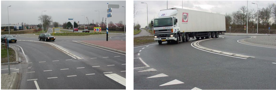
Σχήμα 2.61. Στην Ολλανδία χρησιμοποιούνται υπερυψωμένα διαχωριστικά (curbs) λωρίδων εντός του κόμβου, προσπελάσιμα από βαρέα οχήματα (Fortuijn, 2011).
