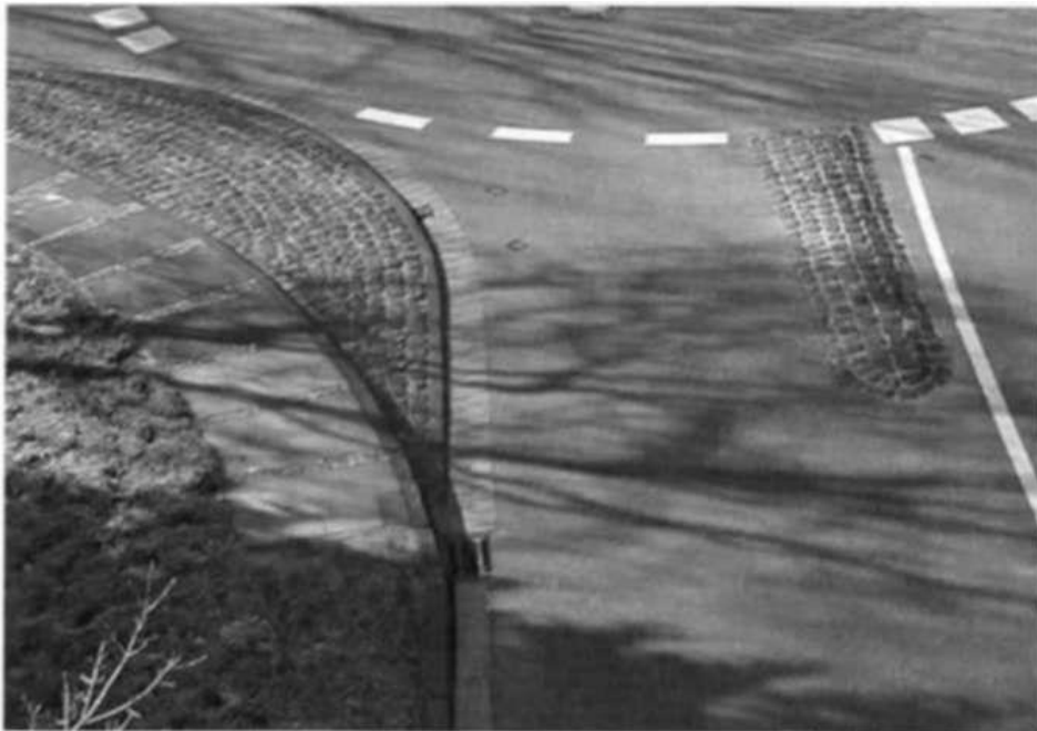
Σχήμα 3.74. Προσπελάσιμη για βαρέα οχήματα επιφάνεια δεξιάς στροφής εξόδου, καθώς και προσπελάσιμη κατευθυντήρια νησίδα (FGSV, 2006).
