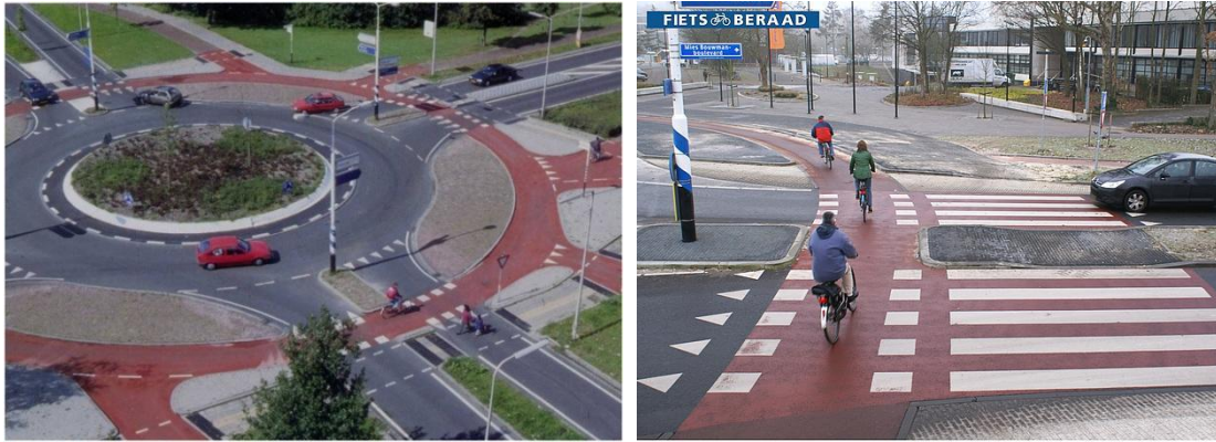
Σχήμα 2.46. Αστικός κυκλικός κόμβος μίας λωρίδας με ποδηλατόδρομο και διάβαση πεζών. Ποδήλατα και Πεζοί διατηρούν προτεραιότητα (Fortuijn, 2011).
