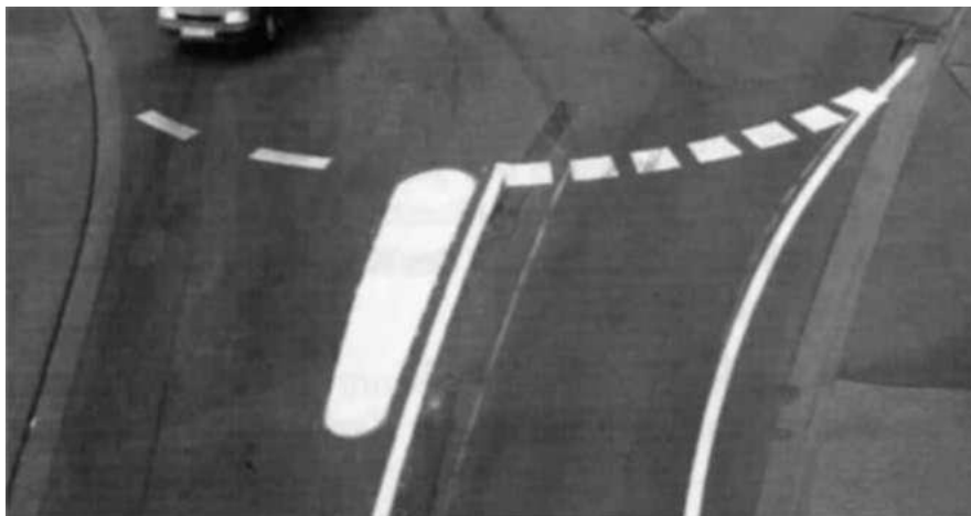
Σχήμα 3.70. Κατευθυντήρια νησίδα με τη μορφή λευκά χρωματισμένης επιφάνειας (FGSV, 2006).
