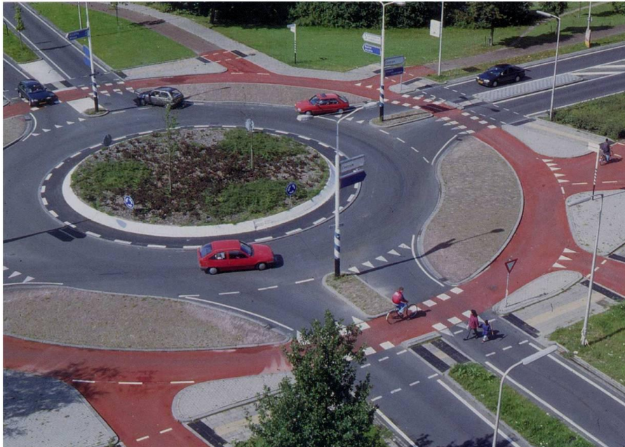
Σχήμα 2.34. Αστικός κυκλικός κόμβος με ποδηλατόδρομο. Ποδήλατα και Πεζοί διατηρούν προτεραιότητα (Fortuijn, 2011).
