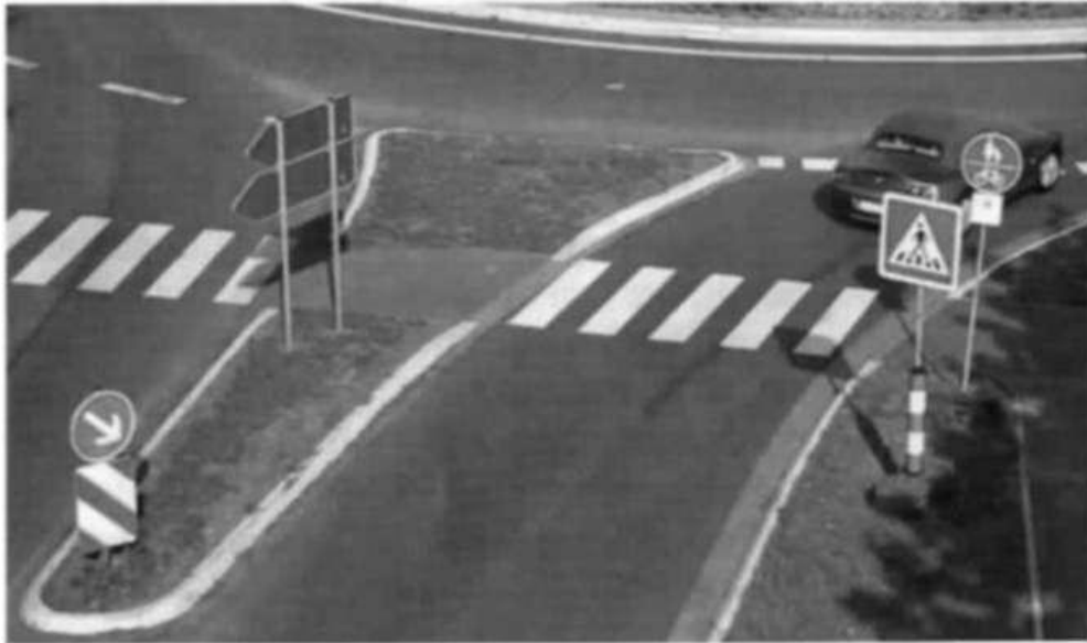
Σχήμα 3.71. Τυπική κατευθυντήρια νησίδα με διάβαση πεζών (FGSV, 2006).
