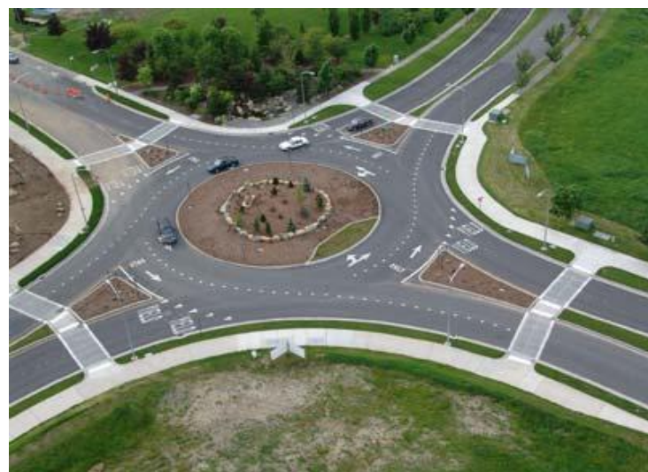
Σχήμα 2.29. Κυκλικός Κόμβος Δύο Λωρίδων (Brilon, 2011).
