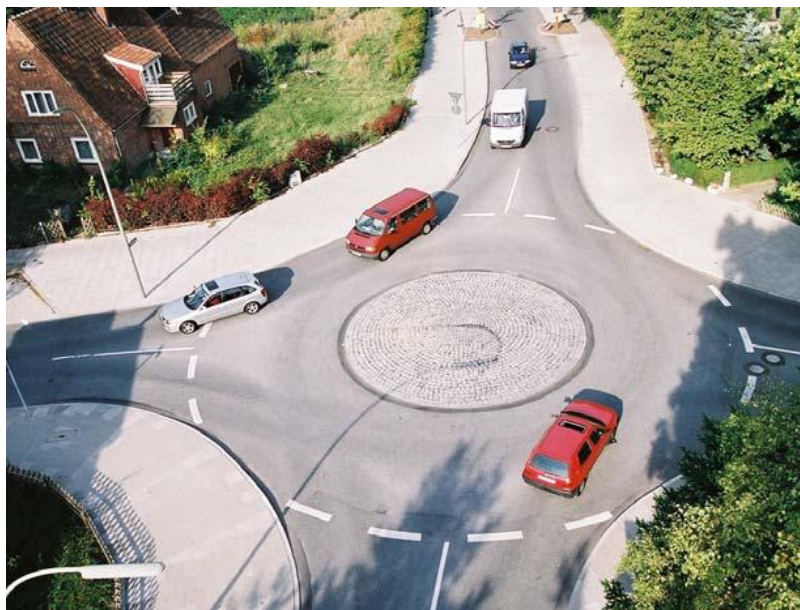
Σχήμα 2.40. Κυκλικός Κόμβος Ελάχιστης Διαμέτρου με ελάχιστο κόστος κατασκευής (Brilon, 2011).
