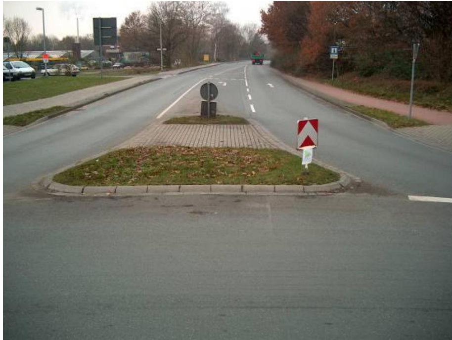
Σχήμα 3.66. Είσοδος – Έξοδος κυκλικού κόμβου μίας λωρίδας (Brilon et al., 2006).
