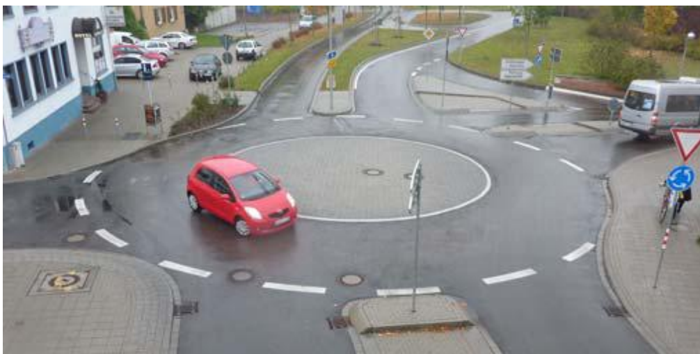
Σχήμα 2.39. Κυκλικός Κόμβος Μικρής Διαμέτρου (Mini Roundabouts) (Brilon, 2011).
