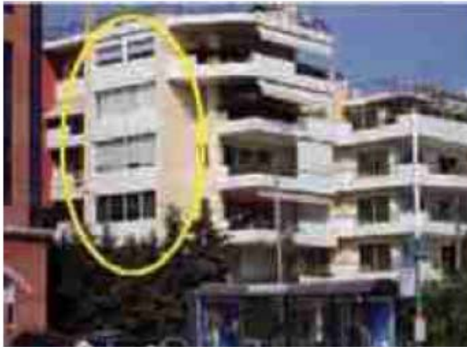
Ημιυπαίθριοι χώροι σε πολυκατοικία
