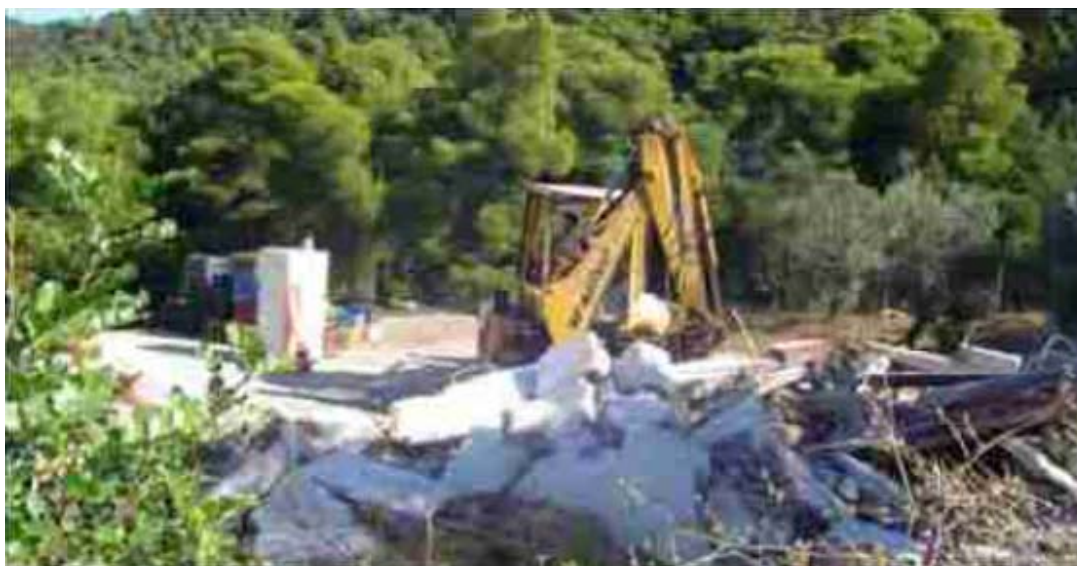
Κατεδάφιση αυθαιρέτου σε δασική περιοχή
