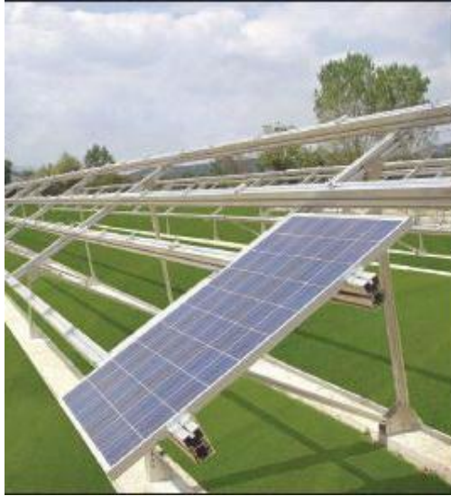
Εικόνα 2.6 Σταθερή δομή στήριξης Φ/Β πλαισίων
