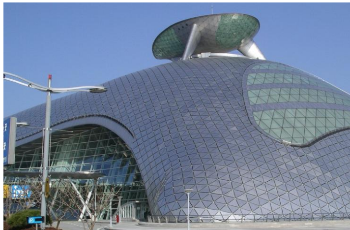
Εικόνα 1.19 Μοντέρνος σχεδιασμός κτιρίων βασισμένος πάνω σε φωτοβολταϊκά
