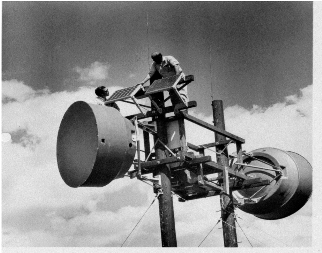
Εικόνα 1.5. Ο John Oakes , στα αριστερά , κάθεται στην κορυφή του ηλιακού αναμεταδότη , καθώς εποπτεύει την εγκατάσταση του ηλιακού αναμεταδότη μικροκυμάτων .
