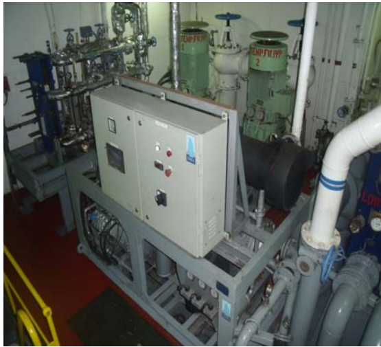
Σχ. 17β. Μέρος του συστήματος εγκατάστασης ψύξεως καυσίμου (Chilling unit) εγκατεστημένο στο πλοίο.
