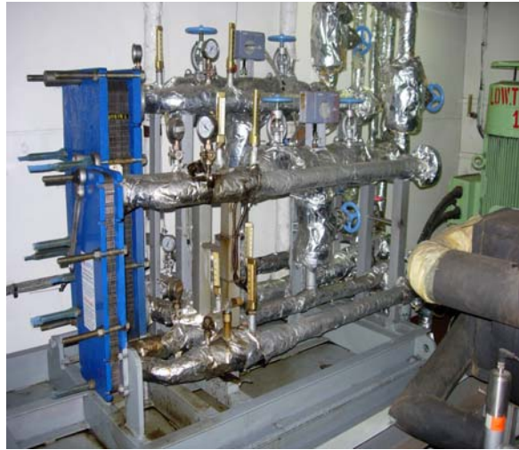
Σχ. 17β. Μέρος του συστήματος εγκατάστασης ψύξεως καυσίμου (Chilling unit) εγκατεστημένο στο πλοίο.
