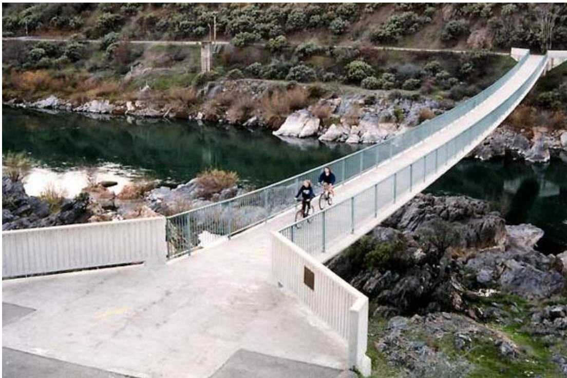
Εικόνα 1.24 Πάκτωση του καταστρώματος στα ακρόβαθρα, ποταμός Sacramento, Αμερική
