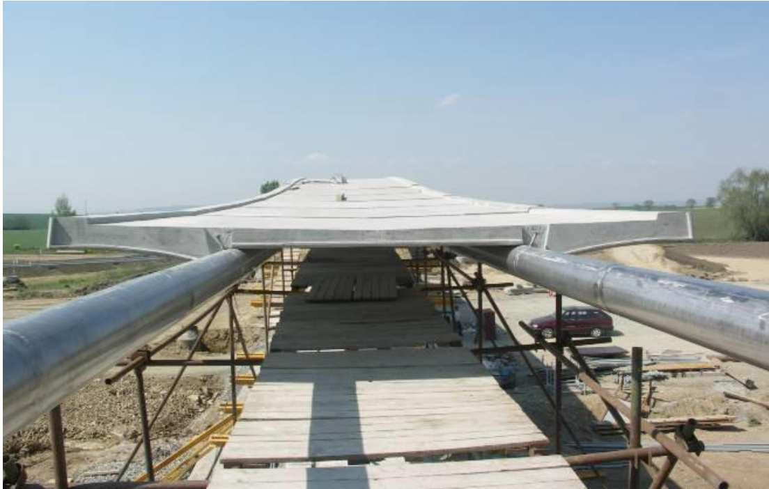
Εικόνα 1.23 προκατασκευασμένοι σπόνδυλοι σε εξωτερικά καλώδια ανάρτησης
