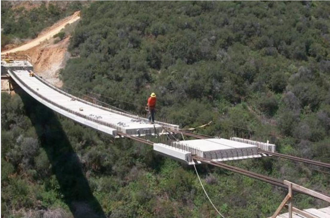
Εικόνα 4. Ανάρτηση προκατασκευασμένων σπονδύλων από τα φέροντα καλώδια.
