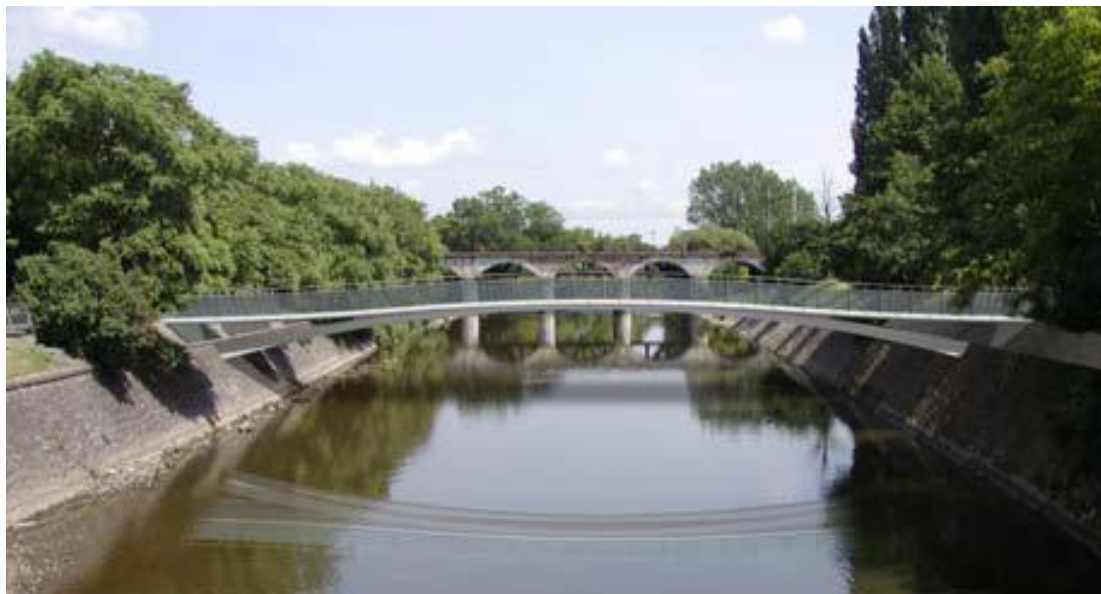
Εικόνα 1.27 Γέφυρα στον ποταμό Svratka ,Τσεχία
