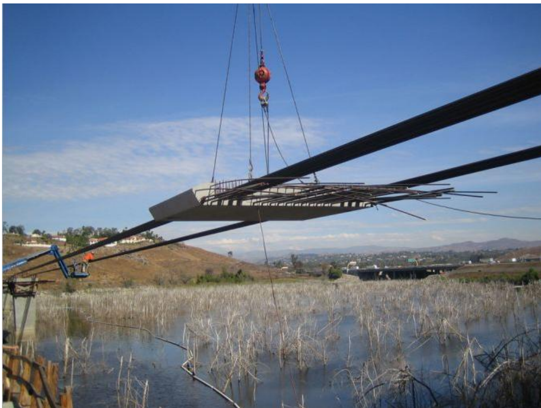
Εικόνα 1.6 Κατασκευή γέφυρας stress ribbon από προκατασκευασμένους σπονδύλους με τη βοήθεια γερανού
