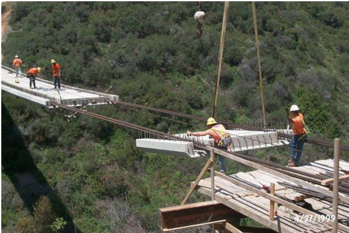
Εικόνα 1.31 Ανέγερση προκατασκευασμένων σπονδύλων με γερανό και τοποθέτηση τους κάτω από τους ταινιοδιαδρόμους (πεζογέφυρα στο San Diego, California, Αμερική)
