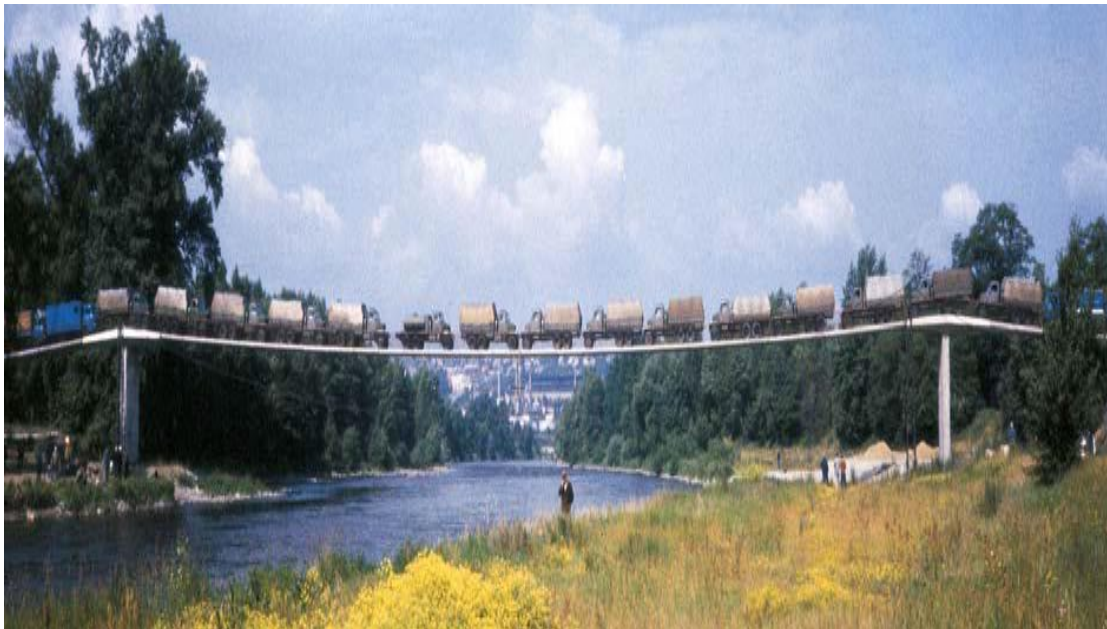
Εικόνα 1.2 δοκιμαστική φόρτιση γέφυρας στην Prague-Troja, Κροατία
