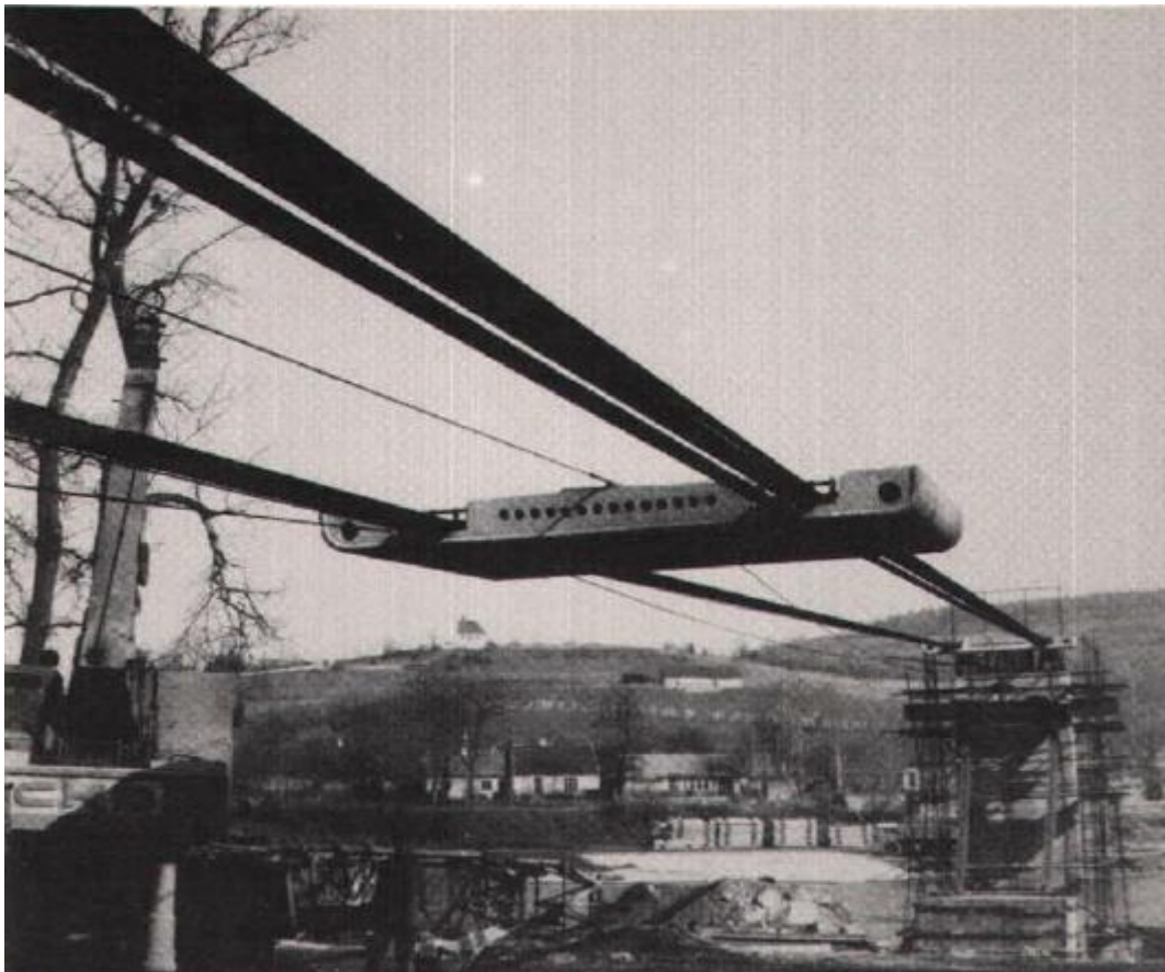
Εικόνα 1.33 προκατασκευασμένος σπόνδυλος σε καλώδια ανάρτησης. Διακρίνεται το σχοινί έλξης στο κέντρο και το βοηθητικό σχοινί στο άκρο της διατομής
