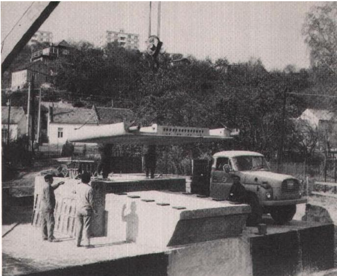
Εικόνα 1.28 τοποθέτηση των ειδικών ακραίων σπονδύλων σε ελαστομεταλλικά εφέδρανα
