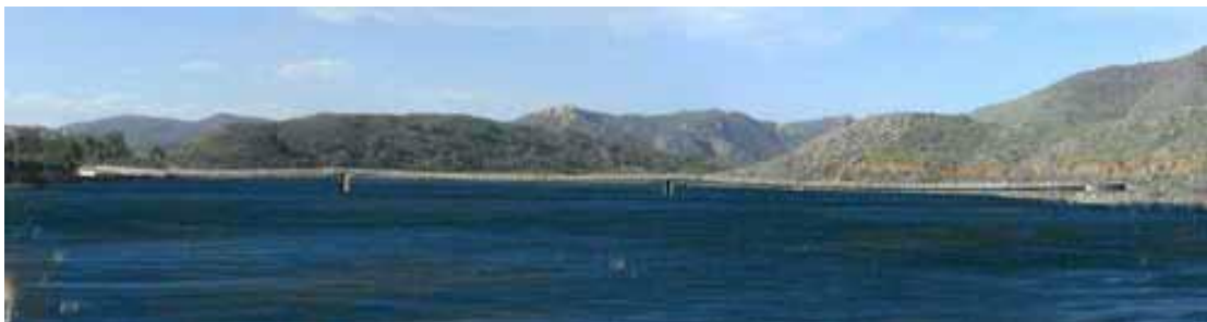
Εικόνα 1.4 Γέφυρα stress ribbon σε υγρό περιβάλλον
