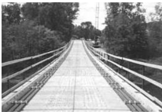
Εικόνα 1.35 Κατάστρωμα πεζογέφυρας Grants pass, Oregon, Αμερική μετά την ανέγερση όλων των σπονδύλων
