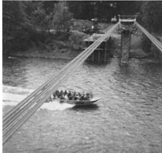
Εικόνα 1.30 φέροντα καλώδια (bearing tendons)
