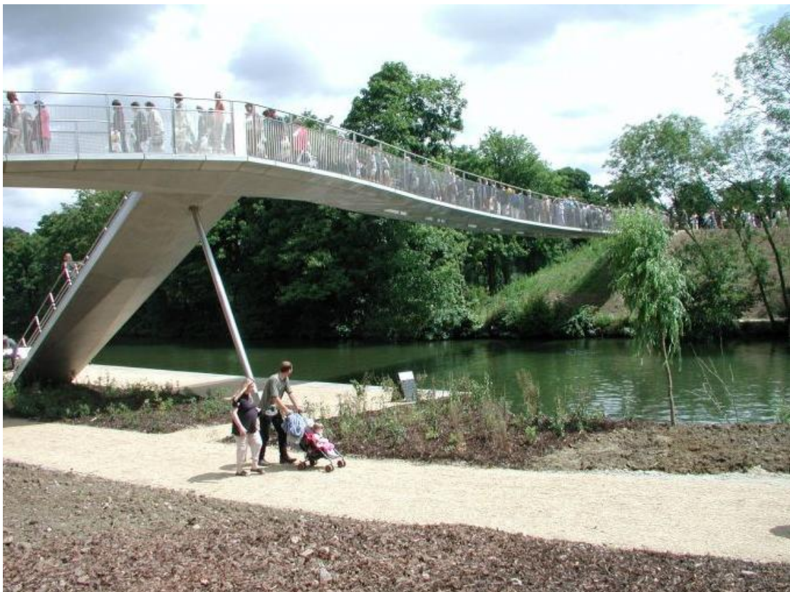
Εικόνα 2.1 Φορτίο πεζών στη φάση λειτουργίας της πεζογέφυρας stress ribbon Maidstone, Kent, Αγγλία.
