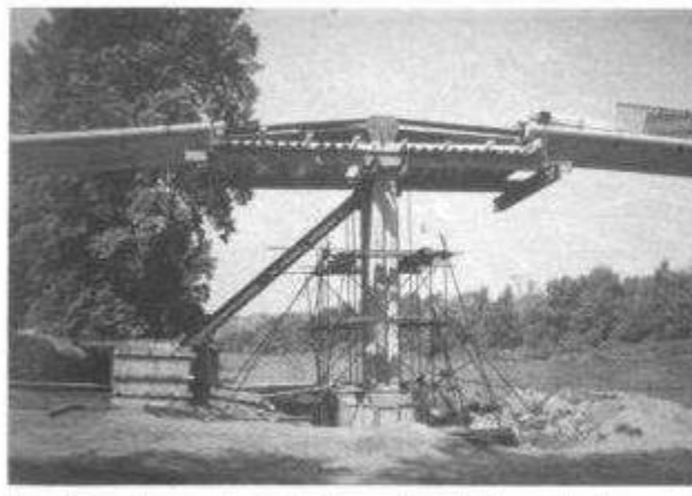
Εικόνα 1.16 Προσωρινή στήριξη βάθρου και ανάρτηση ζυλοτύπου από τα κατασκευασμένα στοιχεία και το βάθρο( γέφυρα Prague-Troja, Τσεχία)
