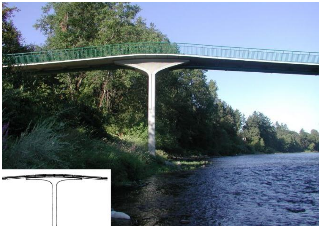
Εικόνα 1.14 περιοχή στήριξης σε μη μονολιθική σύνδεση βάθρου-καταστρώματος (Γέφυρα Grants Pass, Oregon, Αμερική)
