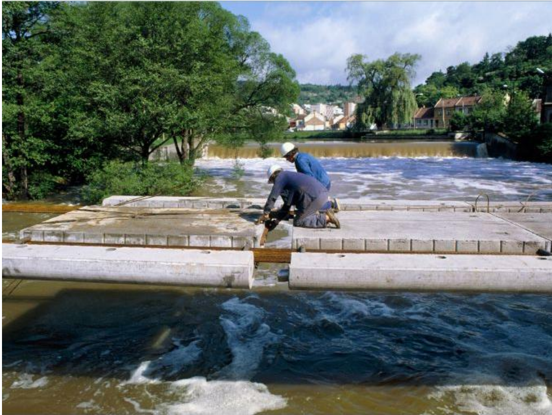
Εικόνα 1.34 τοποθέτηση σωλήνων για τη σύζευξη των τενόντων προέντασης στους αρμούς μεταξύ των προκατασκευασμένων σπονδύλων (γέφυρα Brno-Komín, Τσεχία)
