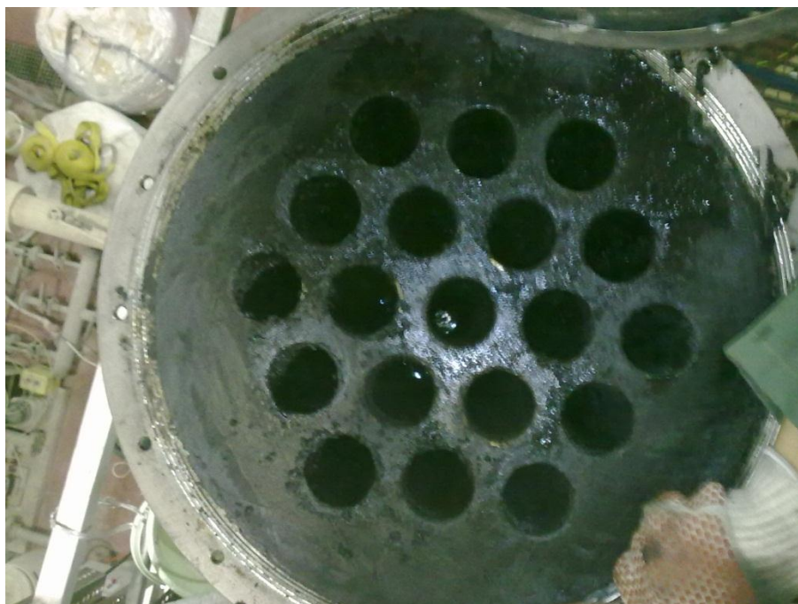
Εικόνα 2. 9 Ο εναλλάκτης εγκατάστασης κατά το άνοιγμα για καθαρισμό
