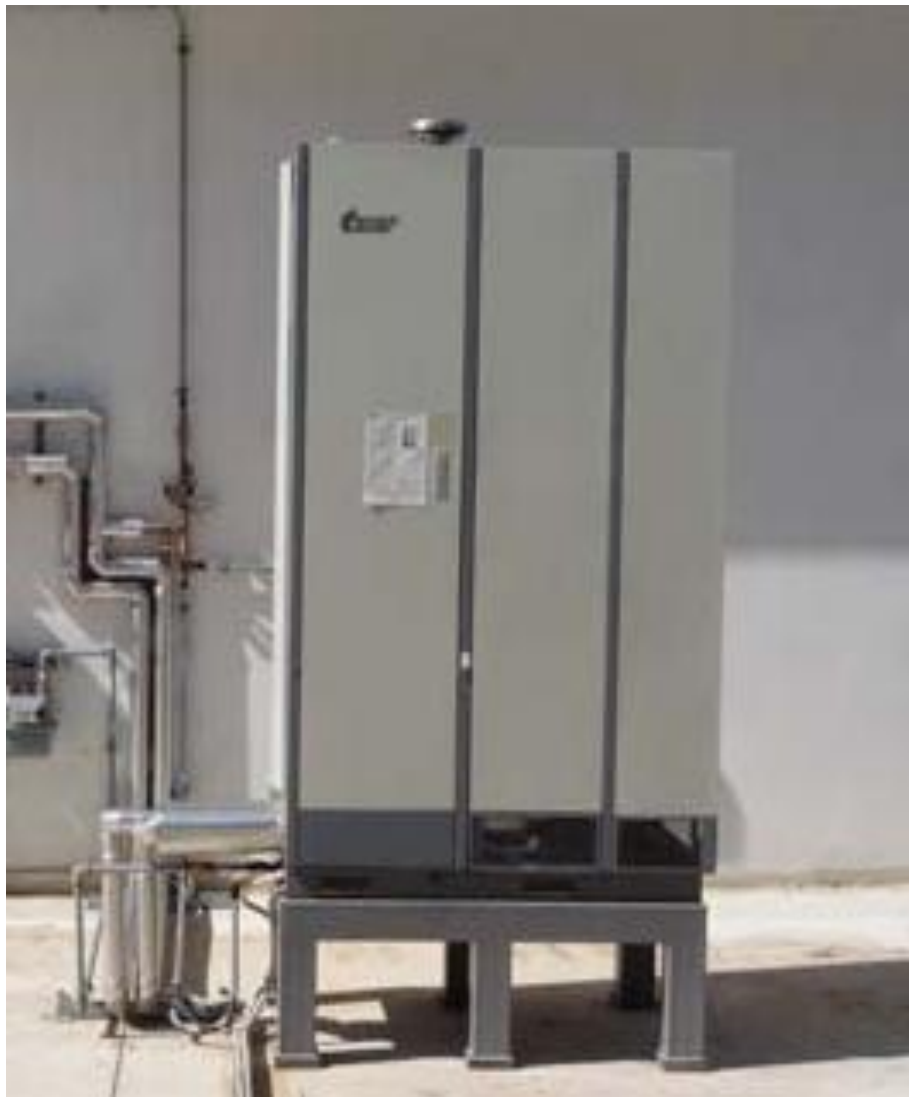
Εικόνα 3.1 : Ψύκτης απορρόφησης BCT-16
