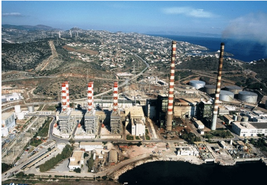
Σχήμα 3.1: Γενική άποψη των εγκαταστάσεων του ΑΗΣ Λαυρίου Figure 3.1: General view of the facilities of the power station at Lavrion (Πηγή: www.metka.gr )
