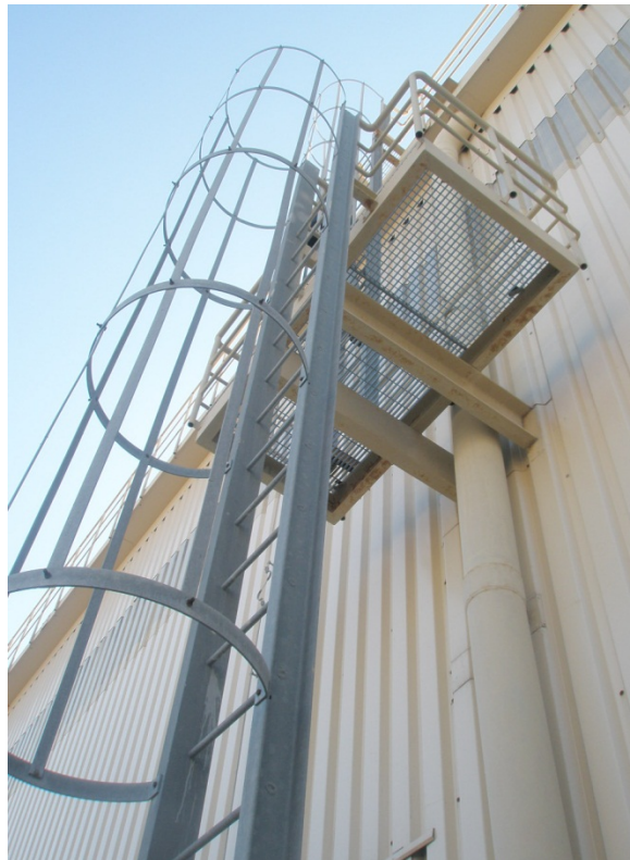
Σχήμα 4.1: Σκάλα για την πρόσβαση στη στέγη Figure 4.1: Ladder to access the roof
