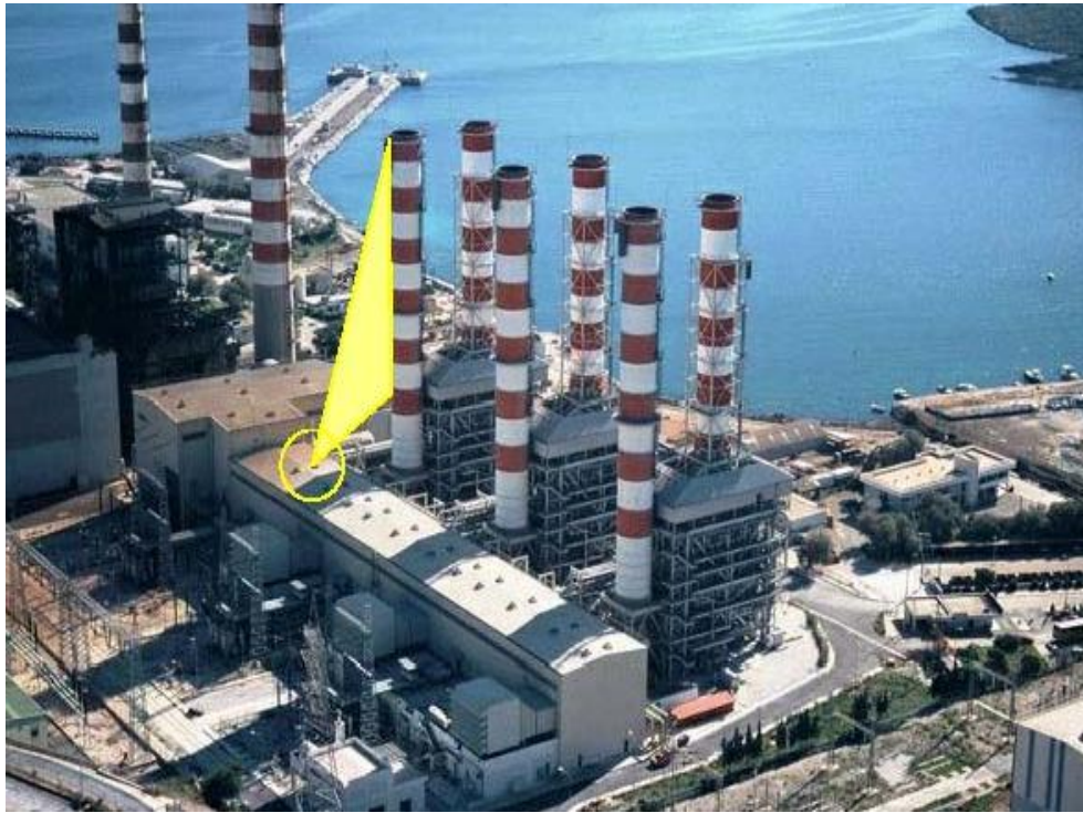
Σχήμα 4.2: Θέση τοποθέτησης του οργάνου (κίτρινος κύκλος) και περιοχή παρατήρησης της καπνοδόχου (κίτρινο τρίγωνο)
