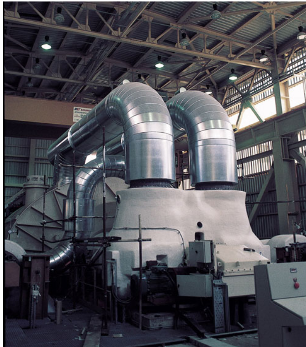
Σχήμα 3.4: Ατμοστρόβιλος της μονάδας IV, τεχνολογίας Alstom Figure 3.4: Steam turbine of the plant IV, Alstom's technology (Πηγή: www.metka.gr )
