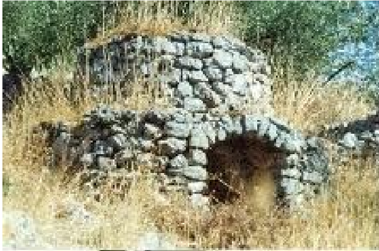
Εικόνα 6: Καμίνι παρασκευής ασβέστη, διακοπτόμενης λειτουργίας.
