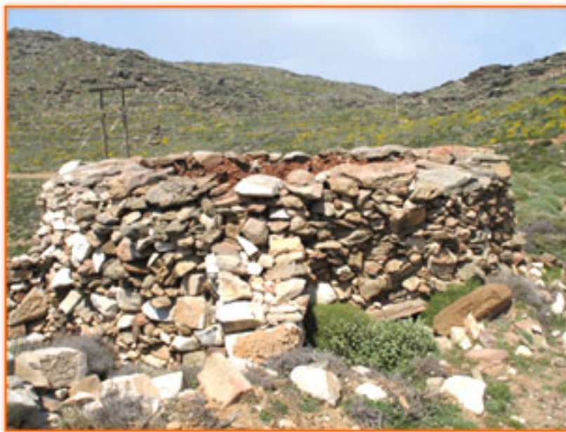
Εικόνα 5 : Σωροκαμίνι παρασκευής ασβέστη. Χρησιμοποιείται για παρασκευή μικρών ποσοτήτων και μόνο όπου είναι δύσκολη η μεταφορά υδρασβέστου .
