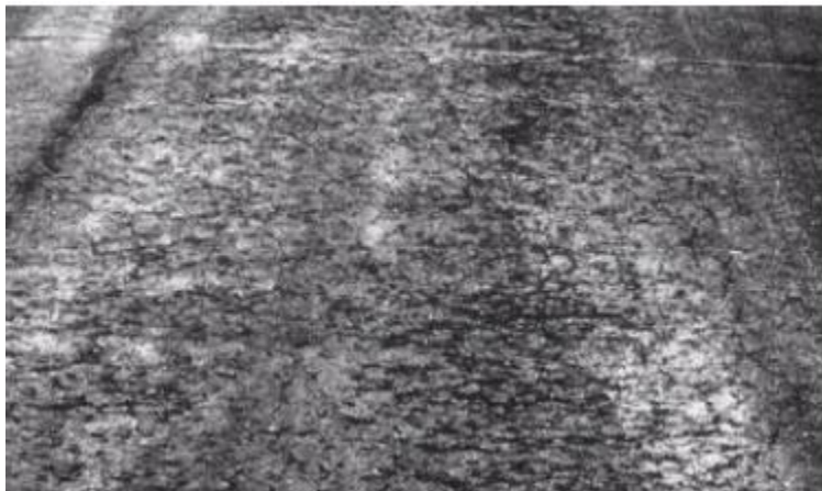
Εικόνα 16 Απόσπαση αδρανών (Πηγή: Yoder, Witczak, 1975)
