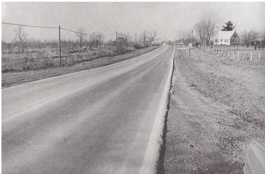
Εικόνα 10 Εφίδρωση μιας ασφαλτικής επιφάνειας (δεξιά λωρίδα) (Πηγή: Yoder, Witczak, 1975)
