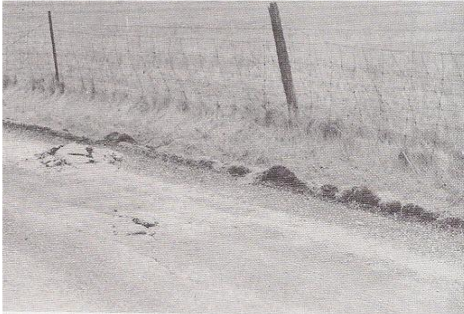
Εικόνα 15 Μικρή διόγκωση παγετού σε εύκαμπτο οδόστρωμα (Πηγή: Yoder, Witczak, 1975)
