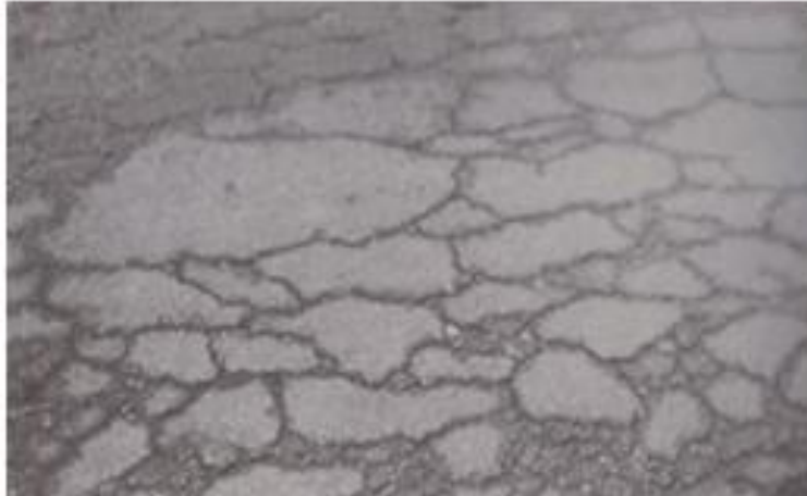
Εικόνα 1 Ρωγμές με μορφή χάρτη ή αλλιγάτορα (Πηγή: Yoder, Witczak, 1975)
