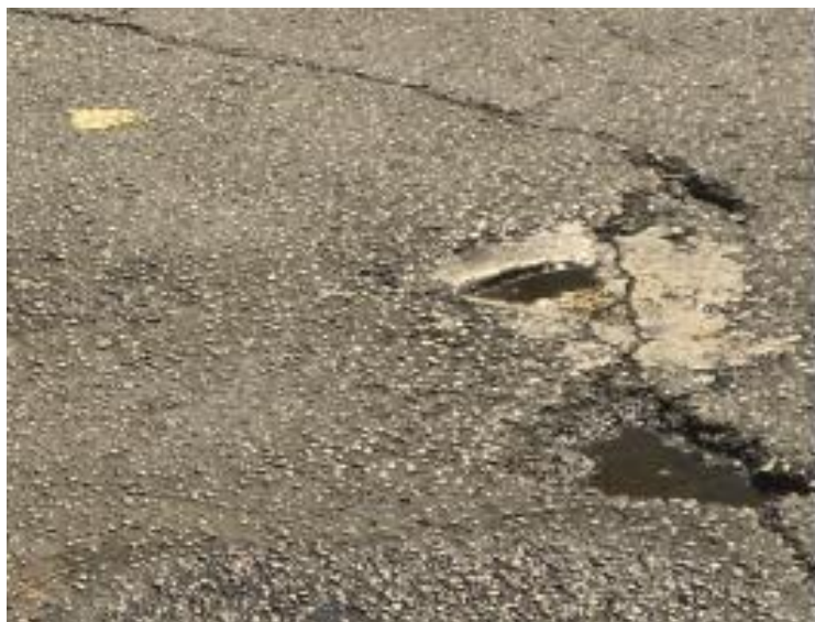
Εικόνα 6.28 Λακκούβες οδοστρώματος
