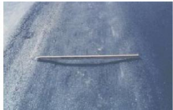
Εικόνα 7 Αυλακώσεις στις τροχιές των τροχών (Πηγή: Ευαγγελίδης, 2004)
