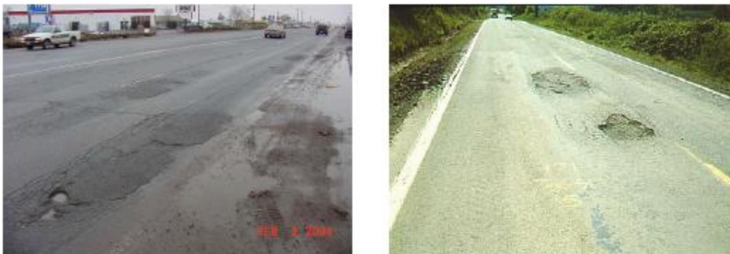
Εικόνα 2.15 Πολύ κακή ποιότητα οδοστρώματος (Πηγή: Oregon, 2010)
