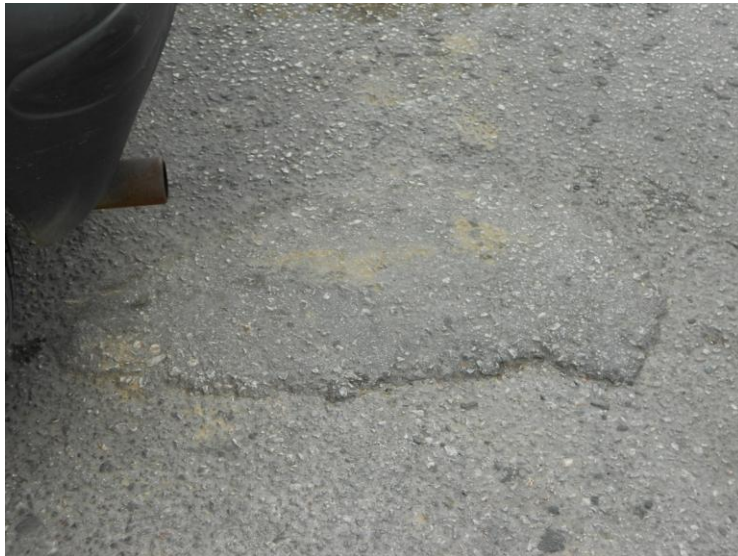
Εικόνα 6.30 Επιφάνεια επισκευής φθορών
