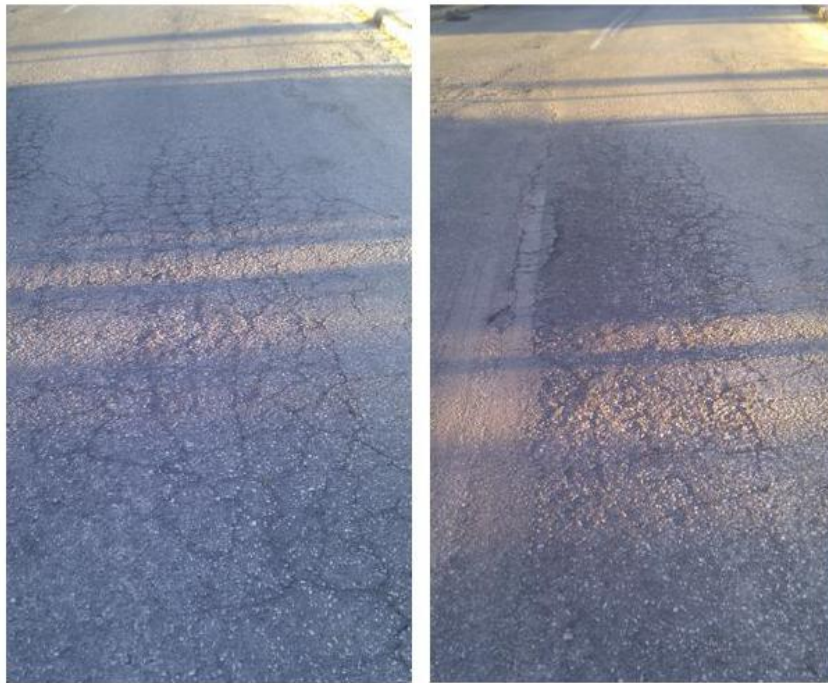
Εικόνα 6.50 Υφιστάμενη κατάσταση δρόμου
