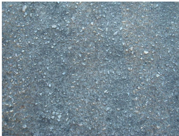
Εικόνα 6.2 Εκδορές οδοστρώματος
