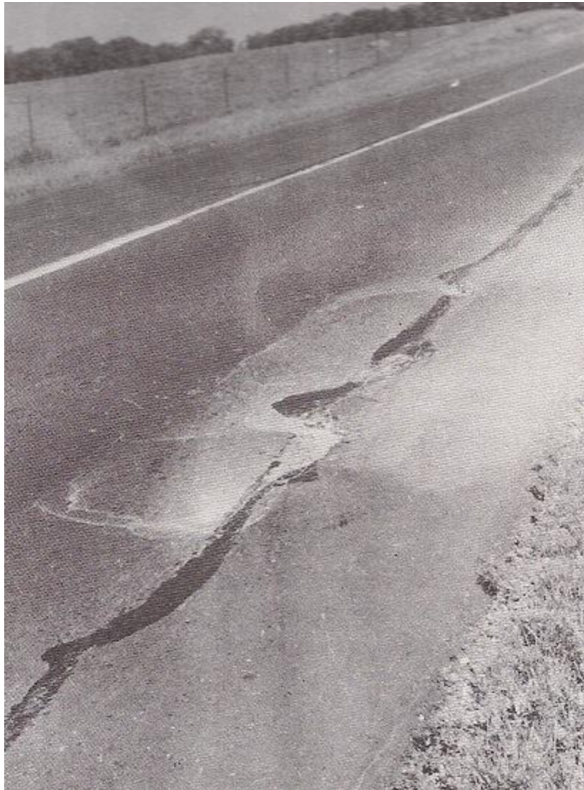
Εικόνα 12 Αποτυχία χαλικώδους επιφάνειας από ανοιξιάντικη τήξη (Πηγή: Yoder, Witczak, 1975)
