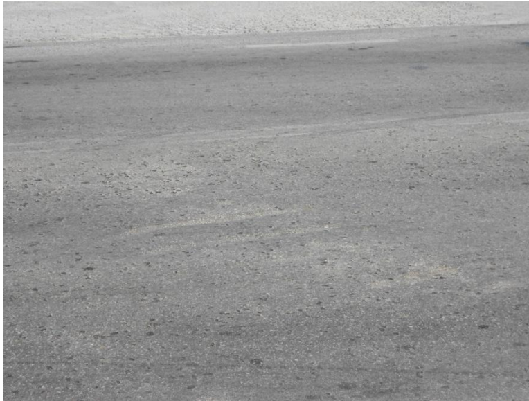
Εικόνα 6.18 Εκδορές οδοστρώματος
