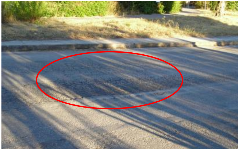
Εικόνα 6.4 Έντονη παρουσία συνθετικών ασφαλτομίγματος
