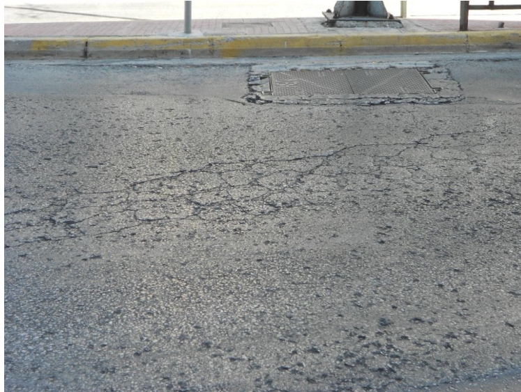
Εικόνα 6.33 Ρηγματώσεις κατά μήκος της πορείας οχήματος
