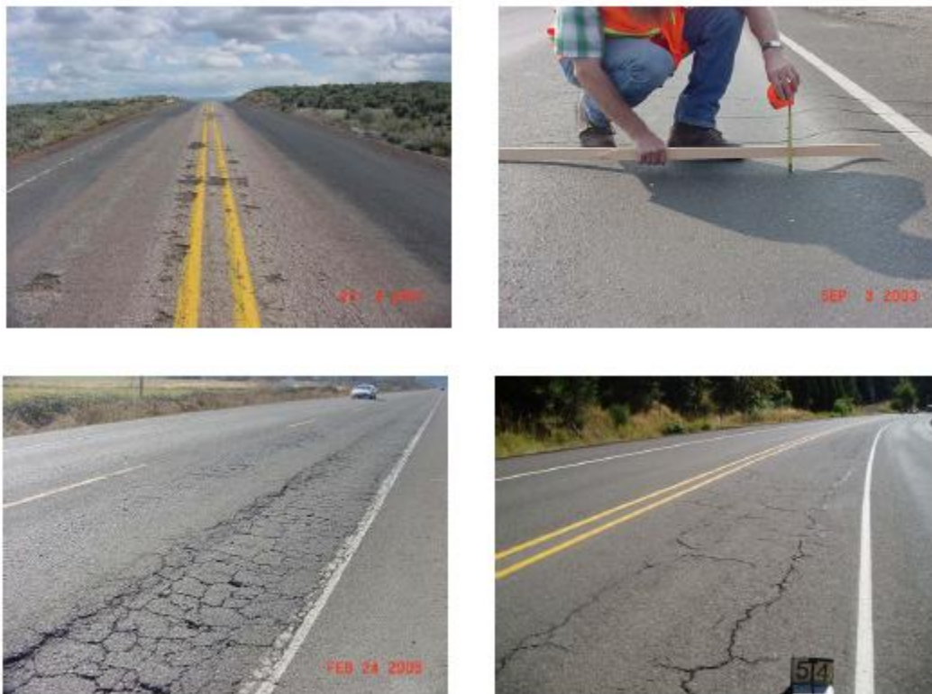
Εικόνα 2.14 Κακή ποιότητα οδοστρώματος (Πηγή: Oregon, 2010)
