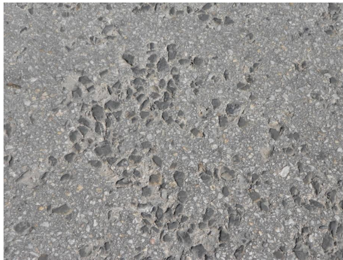
Εικόνα 6.19 Εκδορές οδοστρώματος
