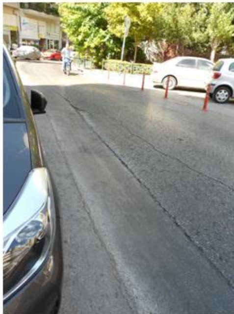
Εικόνα 6.33 Ρηγματώσεις κατά μήκος της πορείας οχήματος
