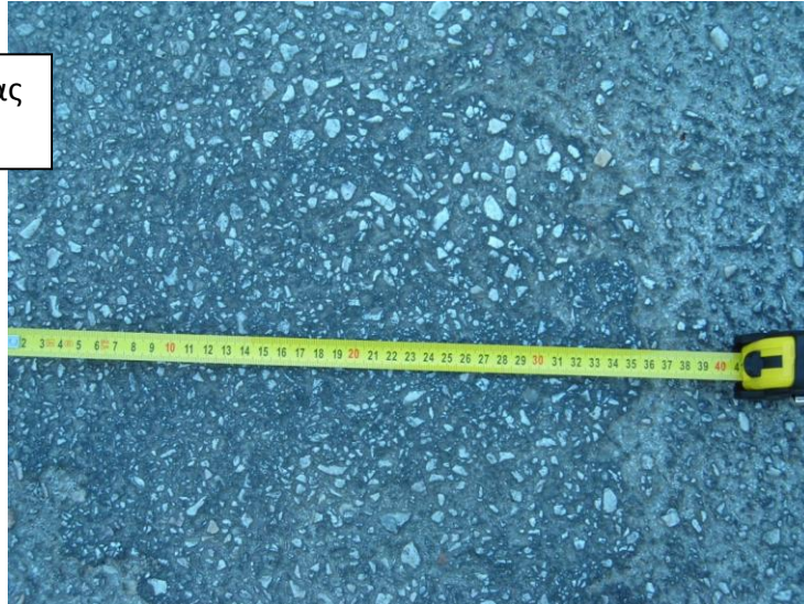
Εικόνα 6.11 Διάσταση πρώτου μπαλώματος
