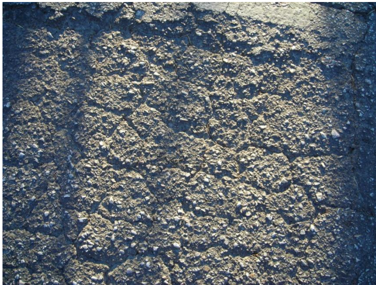
Εικόνα 6.3 Εκδορές οδοστρώματος
