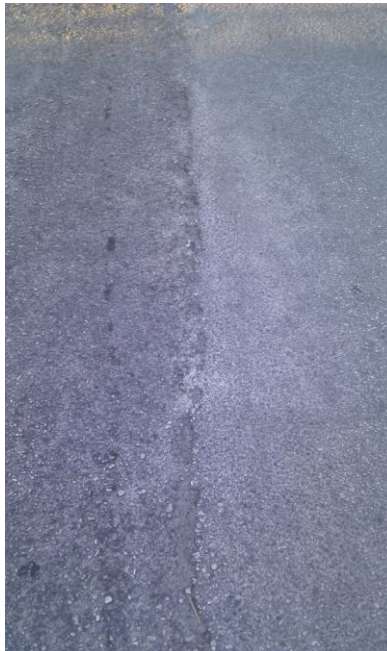
Εικόνα 6.16 Διαμήκης ρηγμάτωση
