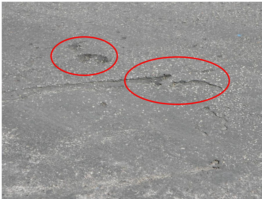
Εικόνα 6.27 Εκδορές οδοστρώματος
