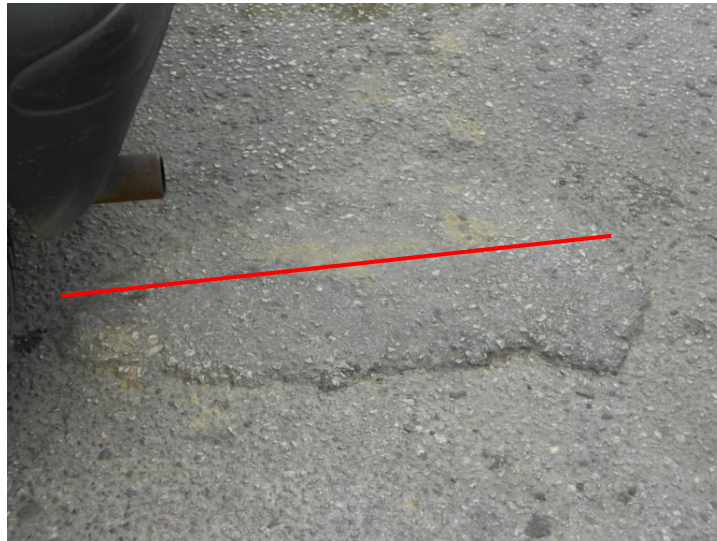
Εικόνα 6.60 Επιφάνεια επισκευής
