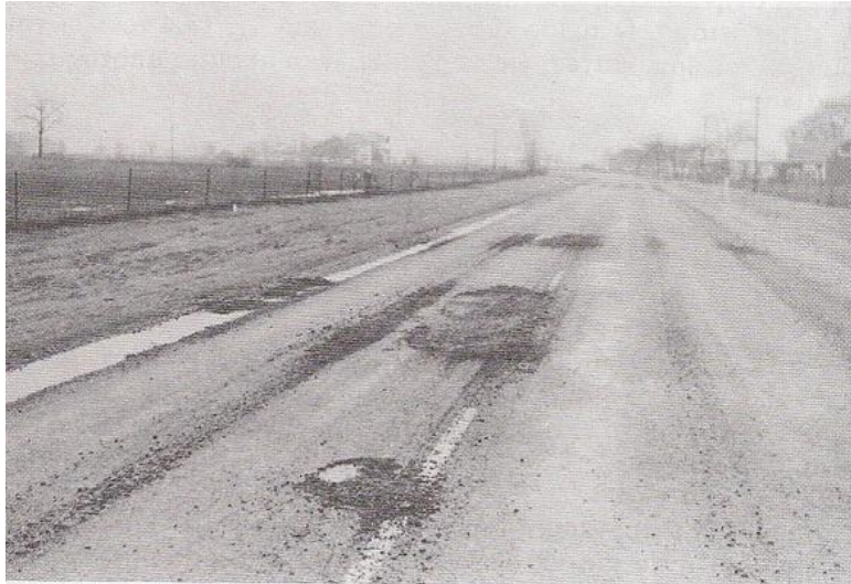
Εικόνα 9 Αποτυχία υπεδάφους από ανοιξιάτικη τήξη (Πηγή: Yoder, Witczak, 1975)
