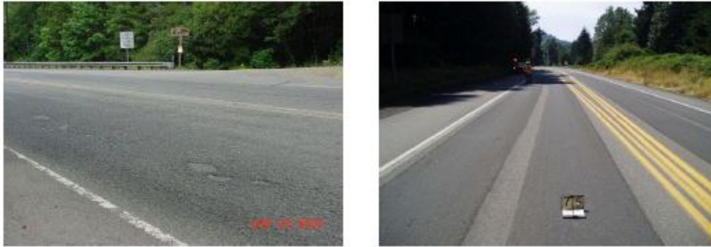
Εικόνα 2.13 Επιτρεπτή ποιότητα οδοστρώματος (Πηγή: Oregon, 2010)
