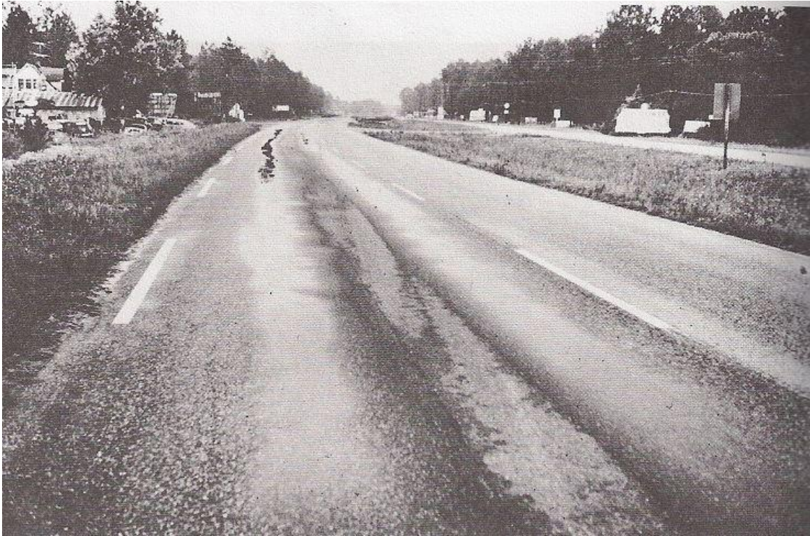
Εικόνα 8 Αυλάκωση σε μία οδό μεγάλης κυκλοφορίας (Πηγή: Yoder, Witczak, 1975)
