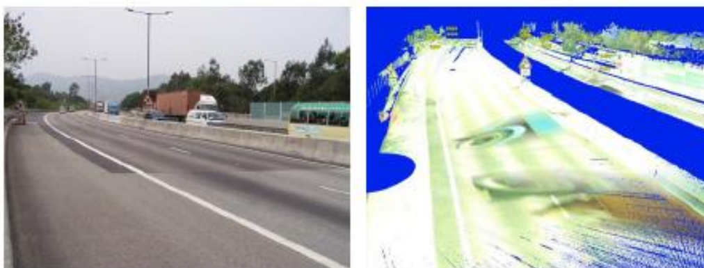
Εικόνα 3.7 Παρουσία καθιζήσεων ασφάλτου σε αυτοκινητόδρομο (Πηγή: Chow, 2007)
