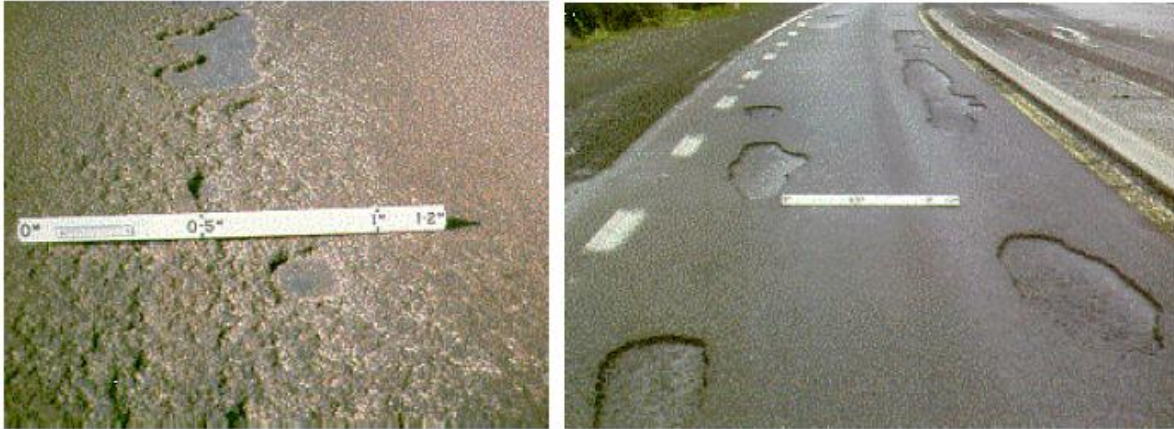
Εικόνα 18 Αποκόλληση κατά πλάκες (Πηγή: Ευαγγελίδης, 2004)
