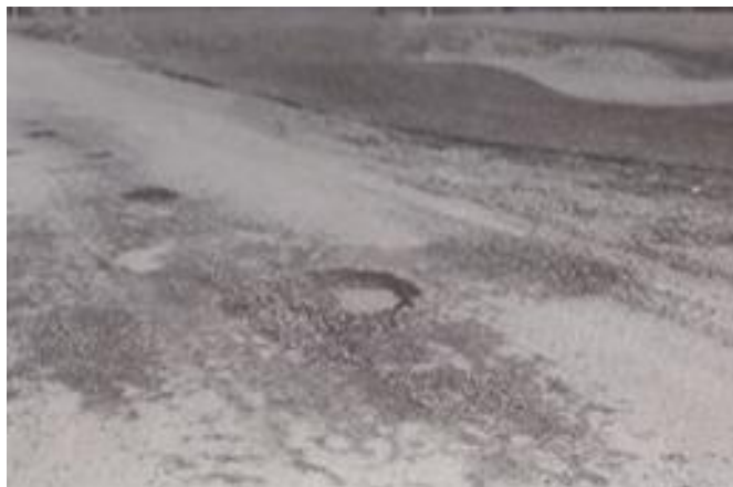
Εικόνα2 Αποτυχία χαλικώδους βάσης (Πηγή: Yoder, Witczak, 1975)
