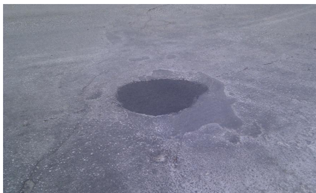
Εικόνα 6.10 Επιφάνεια επισκευών
