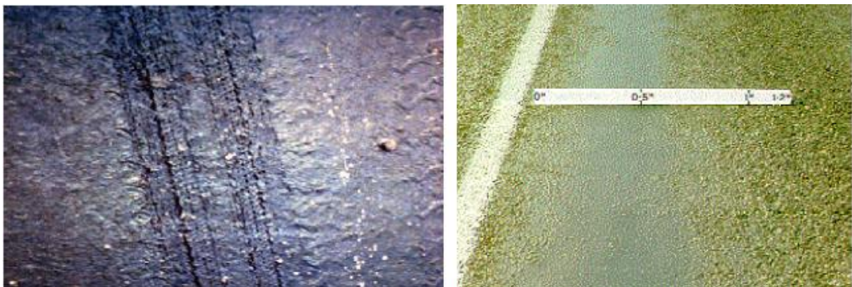
Εικόνα19 Ανάδυση ασφάλτου (Πηγή: Ευαγγελίδης, 2004)
