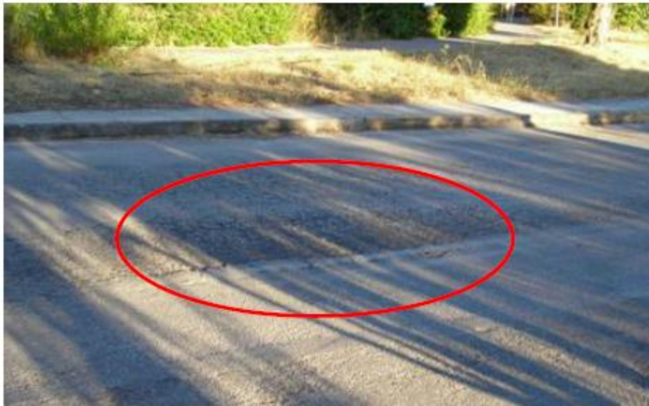
Εικόνα 6.38 Παρουσία συνθετικών ασφάλτου
