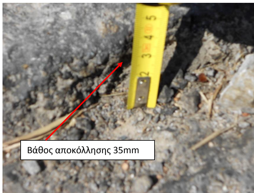
Εικόνα 6.22 Χαρακτηριστικό βάθος αποκολλήσεων
