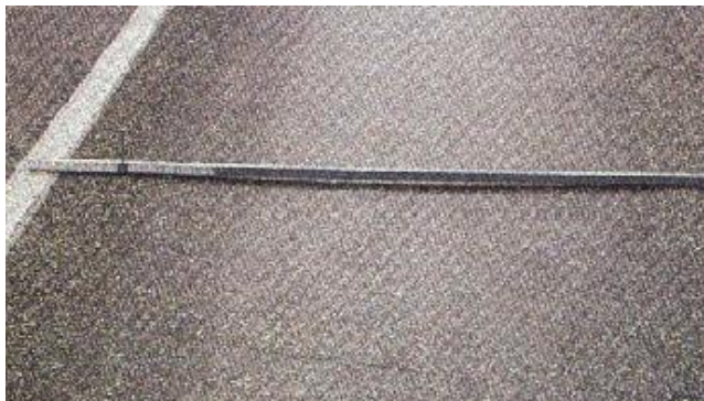
Εικόνα 7 Αυλακώσεις στις τροχιές των τροχών (Πηγή: Ευαγγελίδης, 2004)
