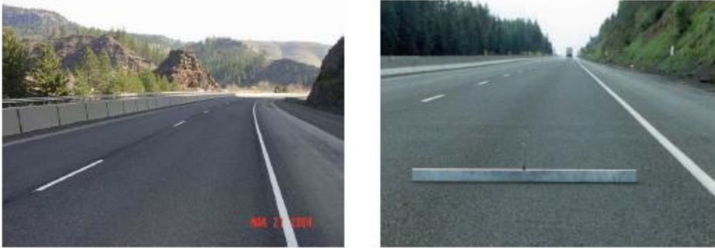
Εικόνα 2.11 Πολύ καλή ποιότητα οδοστρώματος (Πηγή: Oregon, 2010)
