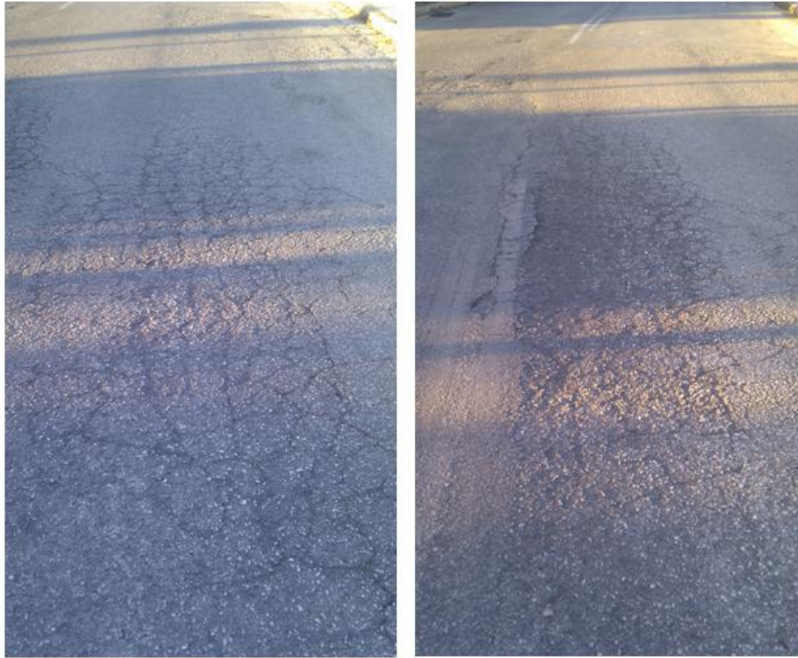
Εικόνα 6.14 Ρηγματώσεις στα ίχνη τροχού
