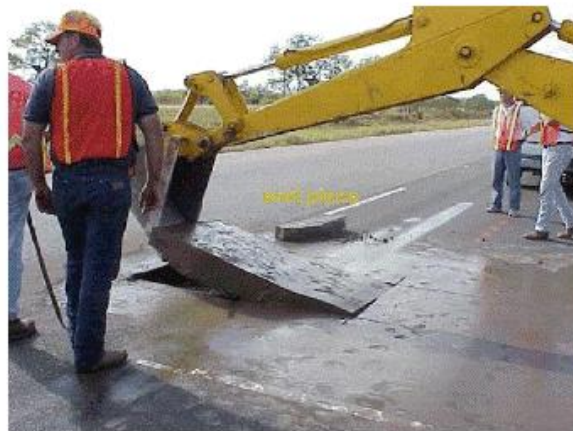
Εικόνα 2.9 Απομάκρυνση ασφαλτικού κομματιού (Πηγή: Lenz, 2011)
