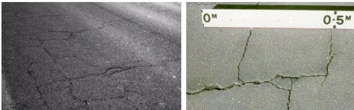
Εικόνα 3 Ρωγμές συστολής ή συρρίκνωσης (Πηγή: Ευαγγελίδης, 2004)
