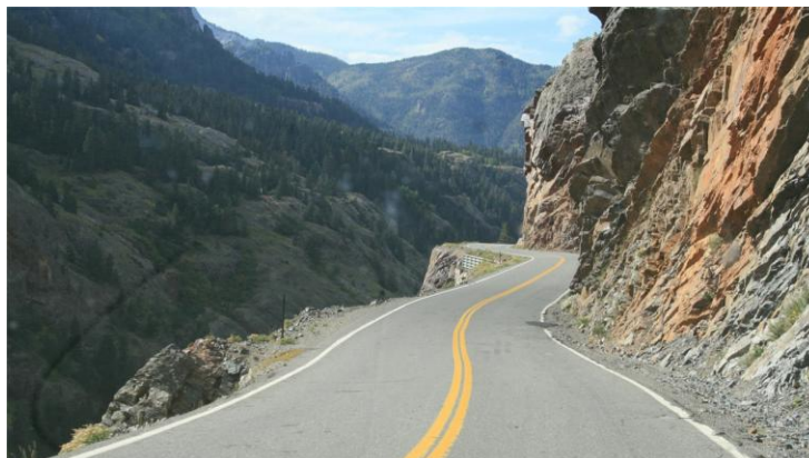
Εικόνα 19: Έντονος τραυματισμός τοπίου λόγω επιχωμάτων και ορυγμάτων Πηγή: http://www.asphaltconstructors.com/completed_projects.htm
