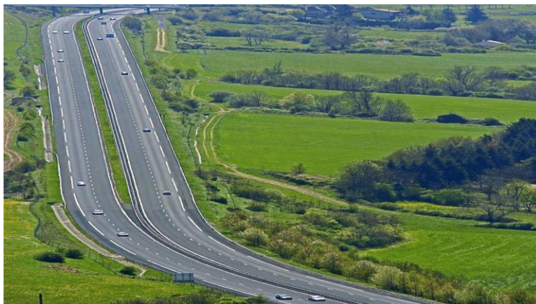
Εικόνα 15: Διαιρεμένη οδός 2 λωρίδων ανά κατεύθυνση που καταλαμβάνει μεγάλη έκταση γης Πηγή: http://lavca.org/2009/07/06/citi-infrastructure-partners-completes-chilean-highway-sale-to-abertis-atlantia/
