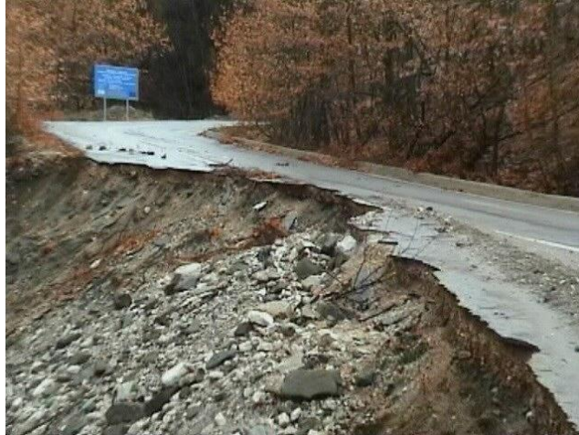
Εικόνα 20: Διάβρωση εδάφους εκατέρωθεν τμήματος οδικού άξονα στο νομό Καρδίτσας Πηγή: http://portal.survey.ntua.gr/main/labs/struct/geotech/media/emb_slide_kard3.html
