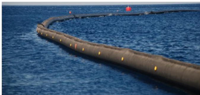
Εικόνα 6.5: Πλωτό φράγμα από κοντά, πηγή: ΙΤΟΡΡ
