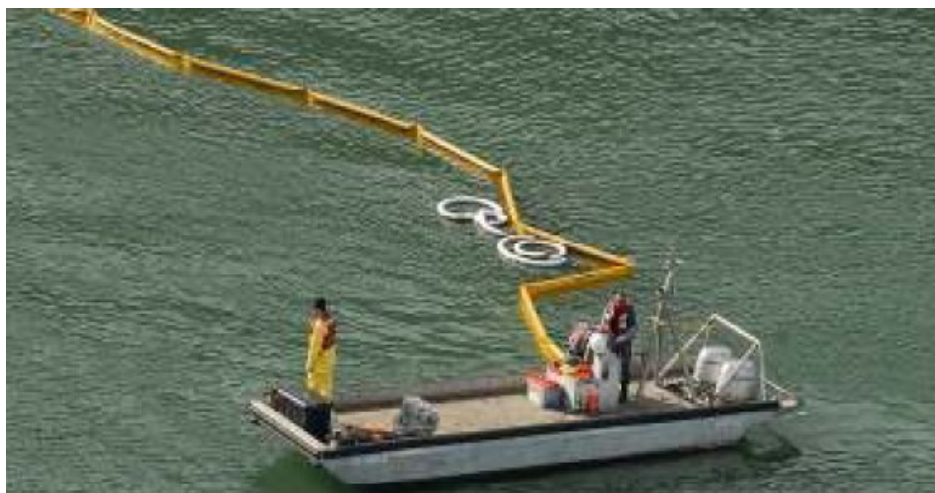
Εικόνα 6.10: Τοποθέτηση φράγματος, πηγή: www.nrt.org
