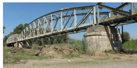
Σχήμα (4.2) - Σιδηροδρομική Γέφυρα Ποταμού Αλφειού
