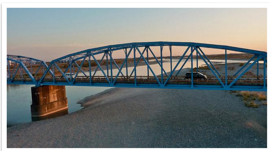
Σχήμα (2.9) - Γέφυρα Tenryu-Gawa, Ιαπωνία
