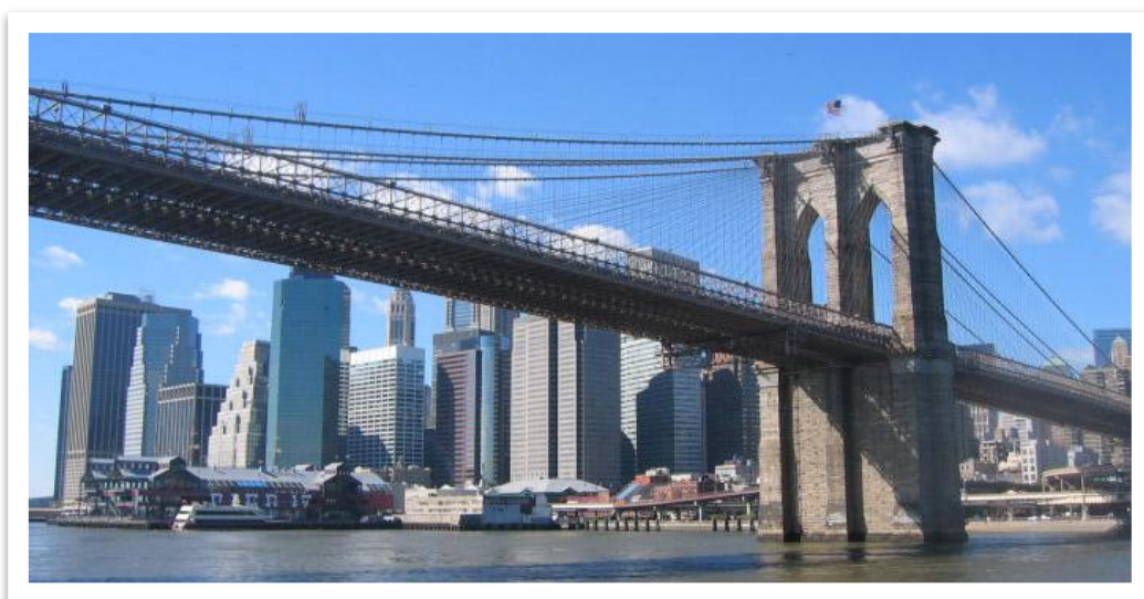
Σχήμα (2.7) - Γέφυρα του Μπρούκλιν, Ηνωμένες Πολιτείες Αμερικής
