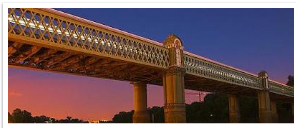
Σχήμα (3.4) - Σιδηροδρομική Γέφυρα Kew, Αγγλία
