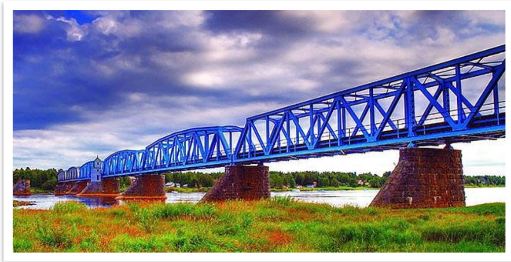
Σχήμα (3.5) - Γέφυρα Hararanda – Tornio, Σουηδία – Φινλανδία
