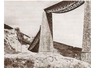
Σχήμα (4.3) Η Σιδηροδρομική Γέφυρα του Γοργοποτάμου μετά από ανατίναξη
