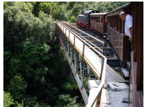
Σχήμα (4.4) Σιδηροδρομική Γέφυρα Ντε Κίρικο
