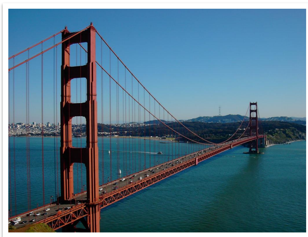
Σχήμα (1.2) - Γέφυρα της Χρυσής Πύλης, Σαν Φρανσίσκο
