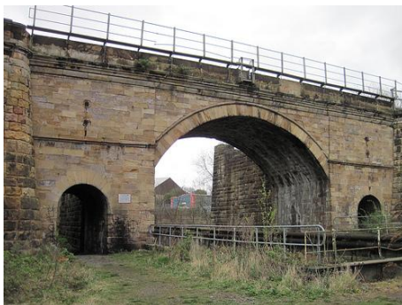
Σχήμα (3.2) - Γέφυρα Skerne, Αγγλία
