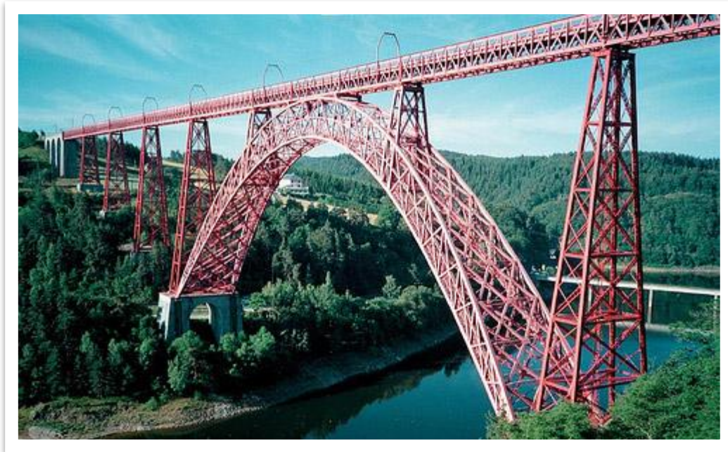
Σχήμα (2.8) - Οδογέφυρα Garabit, Γαλλία
