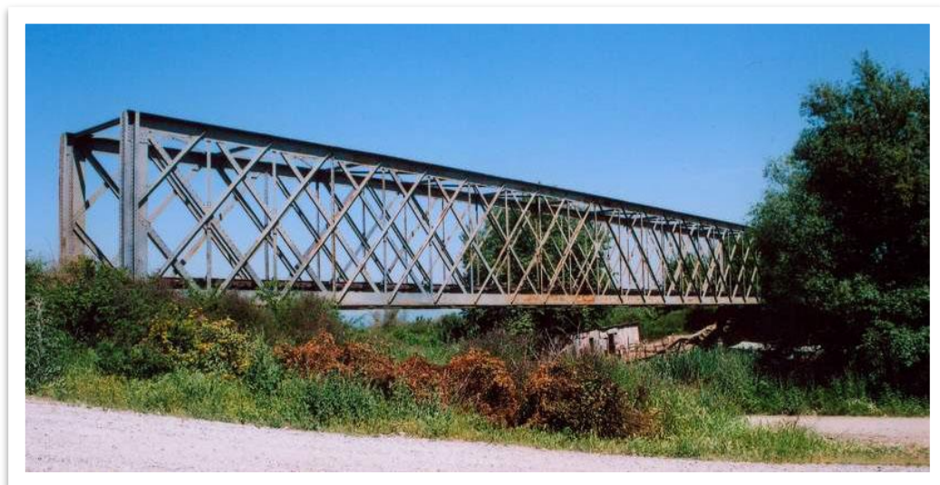
Σχήμα (4.8) - Σιδηροδρομική Γέφυρα Αγγελόκαστρου
