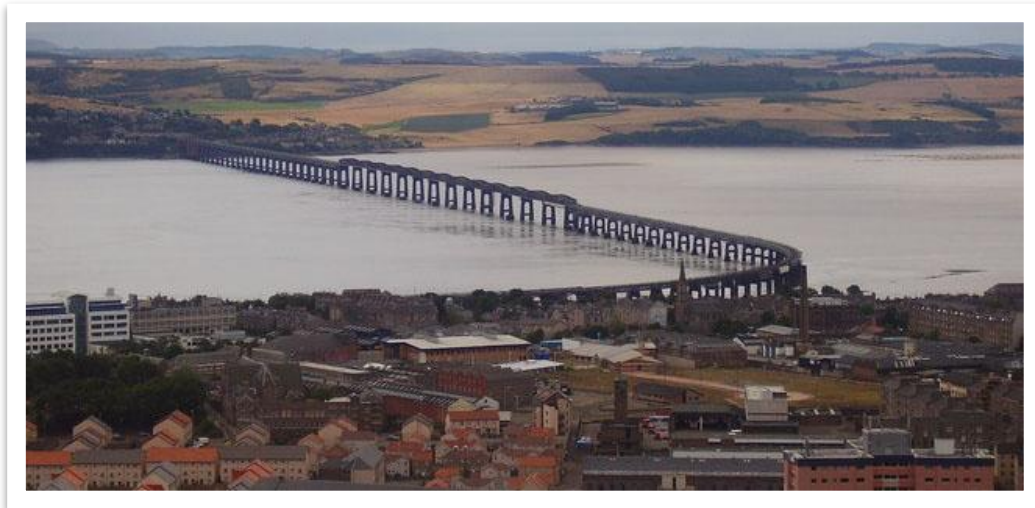
Σχήμα (3.7) - Σιδηροδρομική Γέφυρα Tay, Σκωτία
