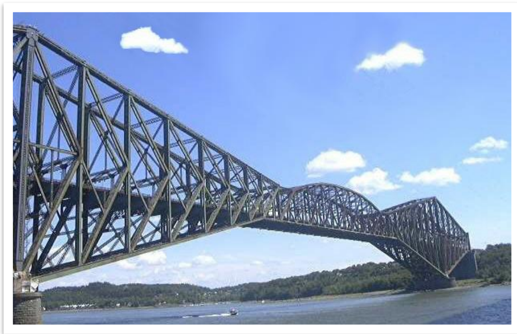
Σχήμα (1.8) - Γέφυρα Κεμπέκ, Καναδάς
