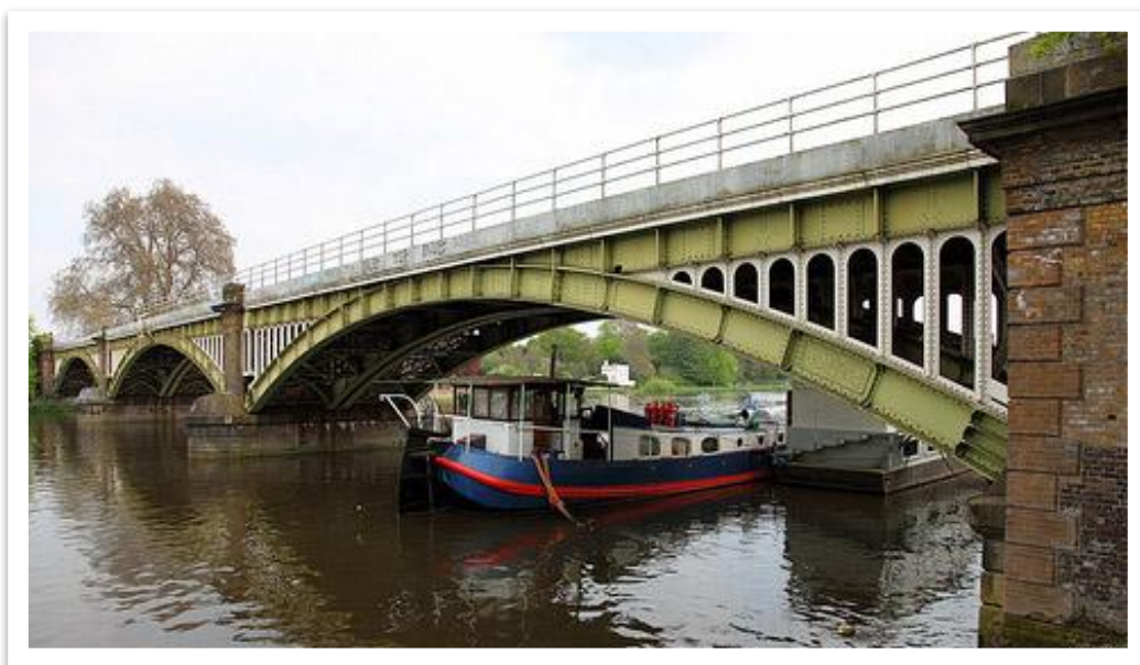
Σχήμα (3.8) - Σιδηροδρομική Γέφυρα Richmond, Αγγλία
