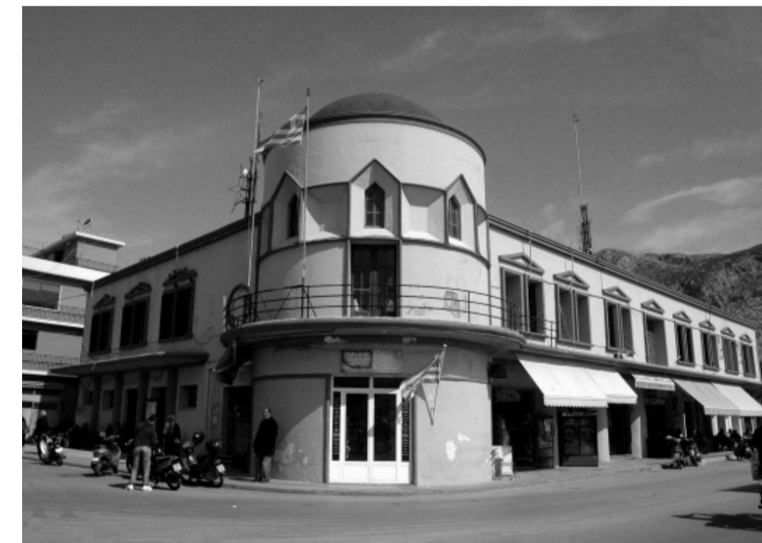
Το Δημαρχείο, χαρακτηριστικό κτίριο της περιόδου ιταλικής κατοχής.
