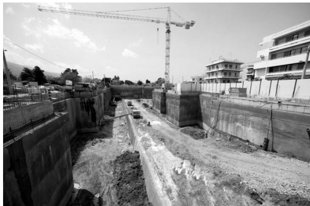
Εικόνα 3.7: Σταθμός Αγία Παρασκευή
