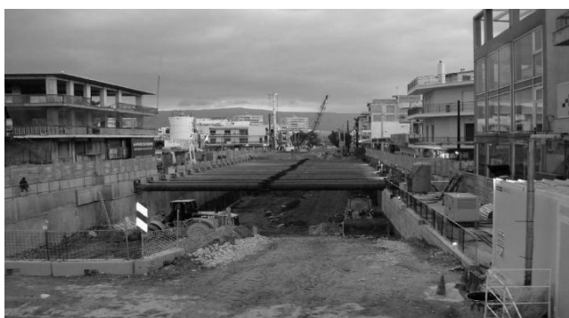
Εικόνα 3.22: Σταθμός Μετρό Ανθούπολης
