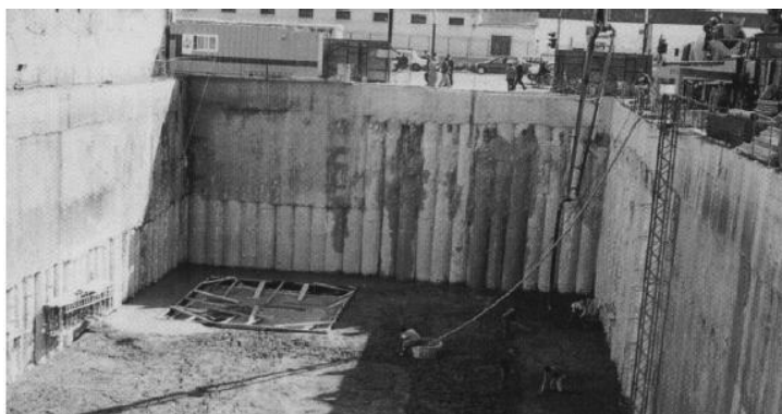
Εικόνα 3.13: Πασσαλότοιχος
