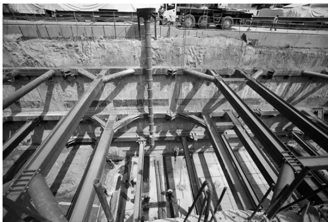
Εικόνα 3.17 Διαφραγματικοί Τοίχοι Μετρό Θεσσαλονίκης
