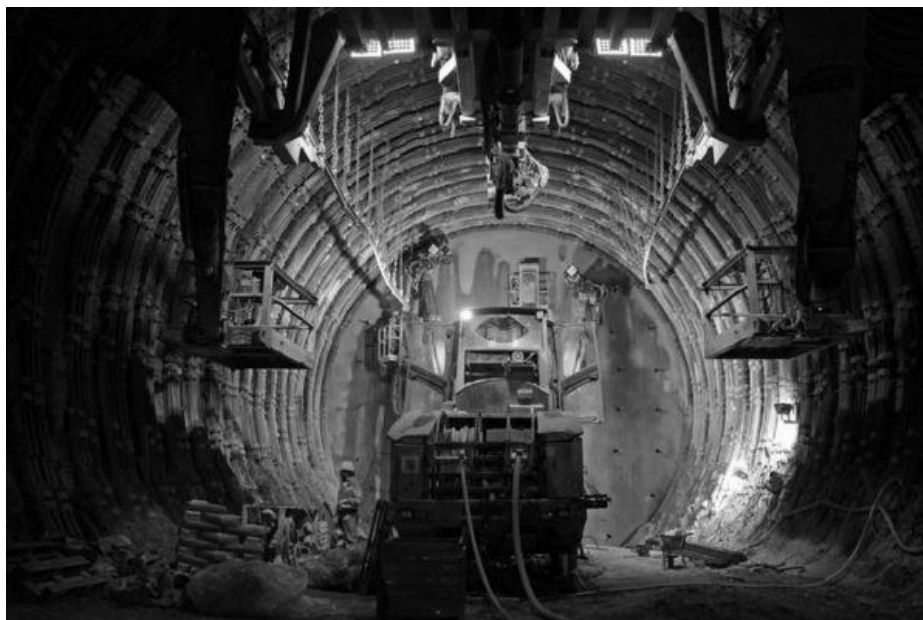
Εικόνα 3.10: Εφαρμογή της μεθόδου NATM στη διάνοιξη του σταθμού 'Σύνταγμα'
