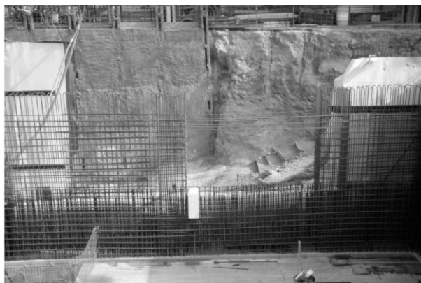
Εικόνα 3.20: Σταθμός Μέγαρο Μουσικής Χαλύβδινα προφίλ με αγκύρια
