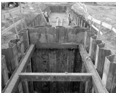
Εικόνα 3.12: Πασσαλοσανίδες
