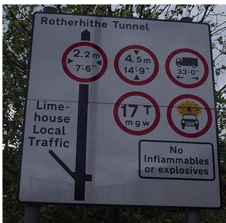
Εικόνα 3.27 Σήμανση που ενημερώνει τους χρήστες για ειδικούς κανονισμούς που ισχύουν κατά τη διέλευση από επερχόμενη σήραγγα
