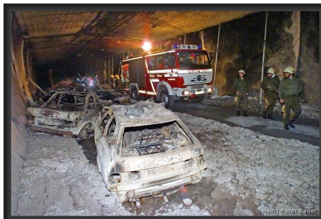
Εικόνα 3.12 Πυροσβέστες ελέγχουν το εσωτερικό της σήραγγας μετά την κατάσβεση
