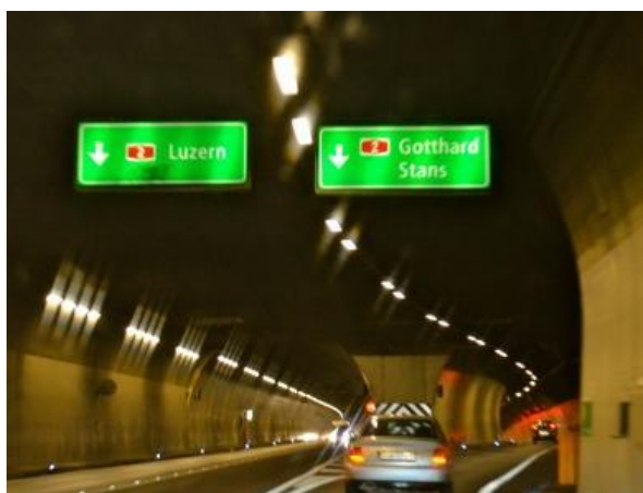
Εικόνα 3.35 Σήμανση εντός σήραγγας
