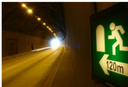
Εικόνα 3.44 Σήμανση που υποδεικνύει την απόσταση έως την πλησιέστερη έξοδο κινδύνου
