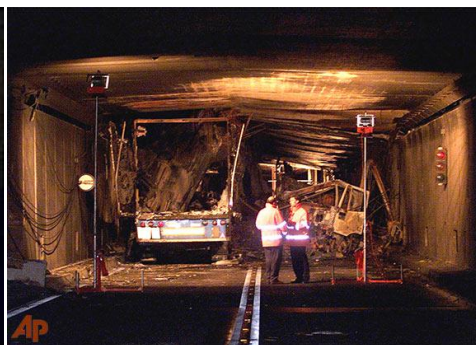
Εικόνα 3.15 Συνεργεία διάσωσης στο εσωτερικό της σήραγγας μετά την κατάσβεση της φωτιάς (St Gotthard tunnel accident 2007)
