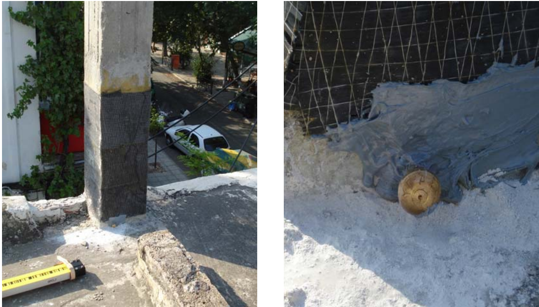
εικόνα 4.4 – Υλοποίηση της υψομετρικής αφετηρίας
