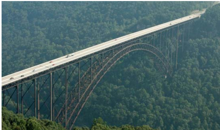
εικόνα 2.2 - γέφυρα New river George (USA)
