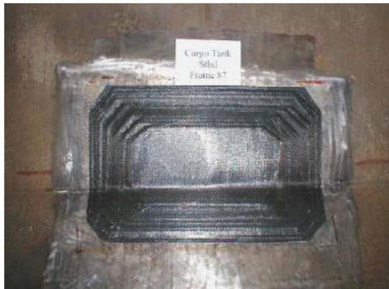
Εικόνα 10 Επίθεμα τοποθετημένο δεξαμενή πλοίου FPSO
