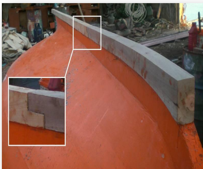
Εικόνα 4.45 Τοποθέτηση κόντρα καρίνας και λεπτομέρεια παρέλας
