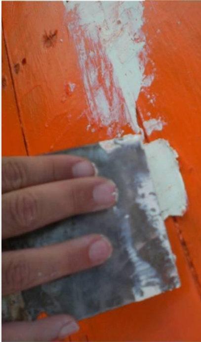
Εικόνα 4.38 Στοκάρισμα
