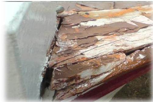
Εικόνα 4.2 Σκασίματα στο χρώμα από τον ήλιο και ξεκαρφωμένο ζωνάρι κουπαστής.
