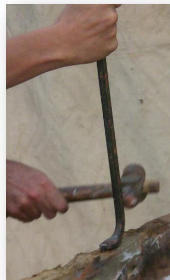
Εικόνα 4.17 Αφαίρεση πρόκας με λοστό και σφυρί
