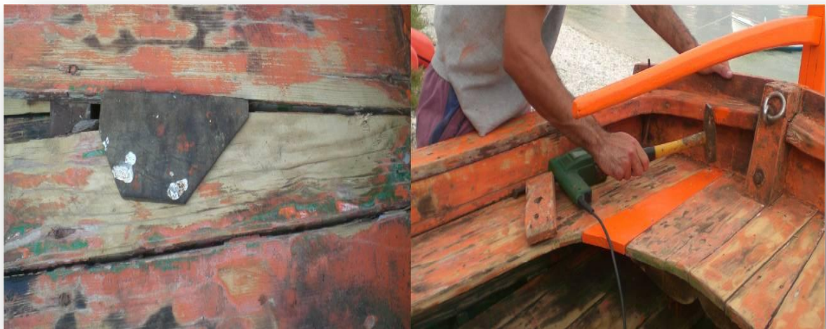
Εικόνα 4.30 Στατζόλα και μαστάρι, αντικατάσταση κομματιού του πάγκου
