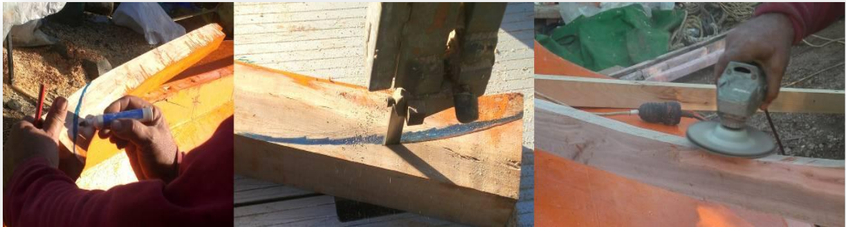
Εικόνα 4.44 Κατασκευή πρωραίου κομματιού κόντρα-καρίνας.
