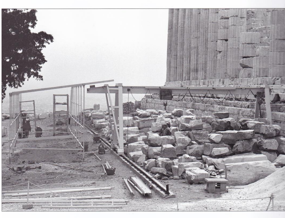
Εικ.1.15: Εγκατάσταση γερανογέφυρας και παραπήγματος εργασίας στη νότια πλευρά του Παρθενώνα. [2]
