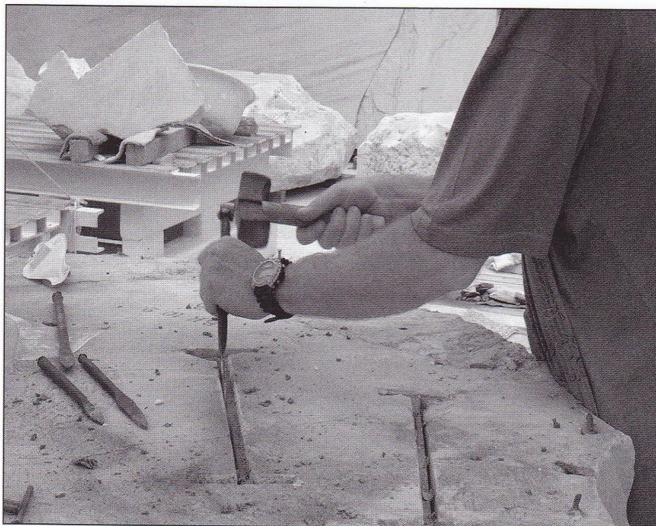
Εικ.1.17: Αφαίρεση σιδηρών στοιχείων με μηχανικό τρόπο. [2]
