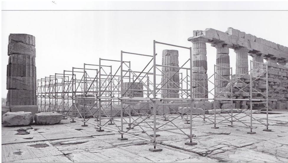
Εικ.1.16: Ικρίωματα για την εγκατάσταση του γερανού στο εσωτερικό του Παρθενώνα. [2]
