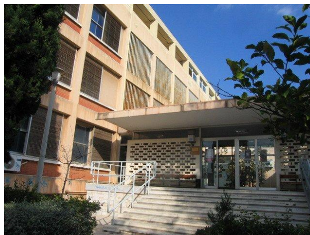
Εικόνα 4.10, Στην φωτογραφία φαίνονται τα μεταλλικά σκίαστρα στην Νότια πλευρά
