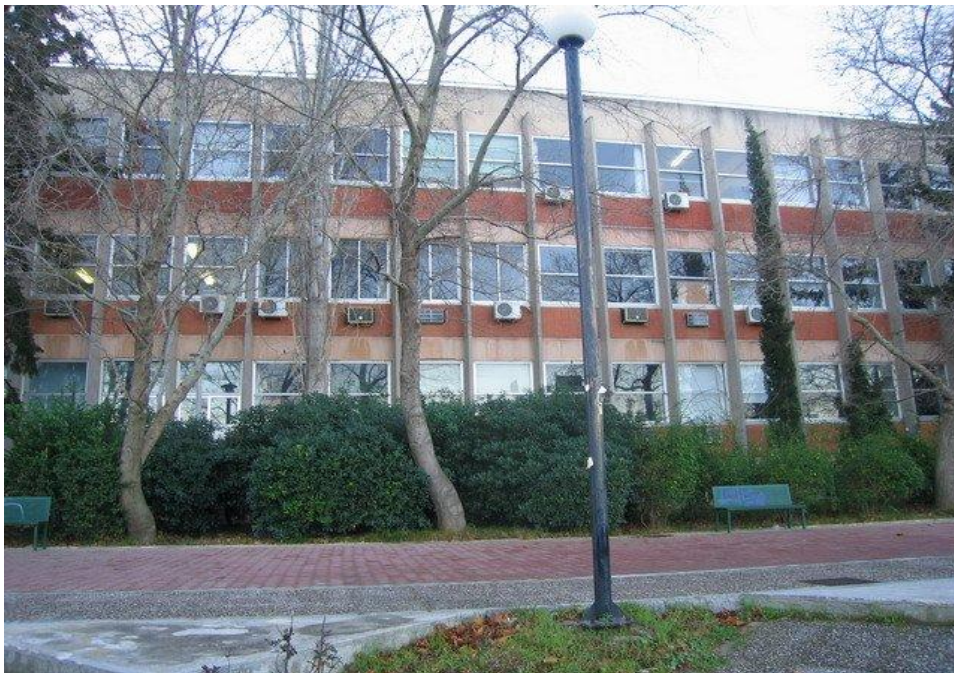
Εικόνα 4.7, Βόρεια πλευρά κτιρίου
