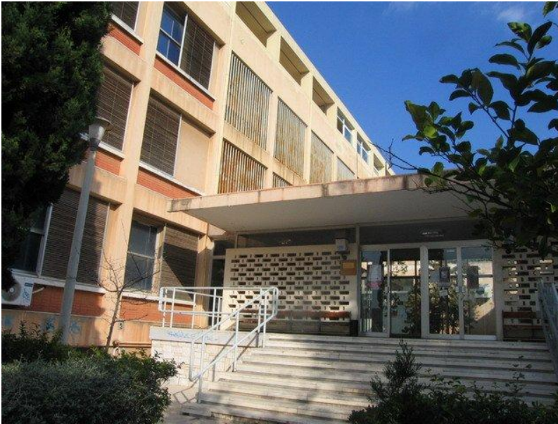
Εικόνα 4.6, Νότιο-Δυτική πλευρά και η κύρια είσοδος του κτιρίου
