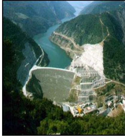
Εικόνα 2.15: ΥΗΣ Σφηκιάς στον Αλιάκμονα [15]
