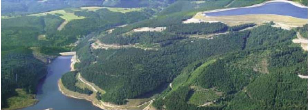
Εικόνα 2.14: Αναστρέψιμο Υ/Η έργο , Goldisthal (Γερμανία, 2002) [5]
