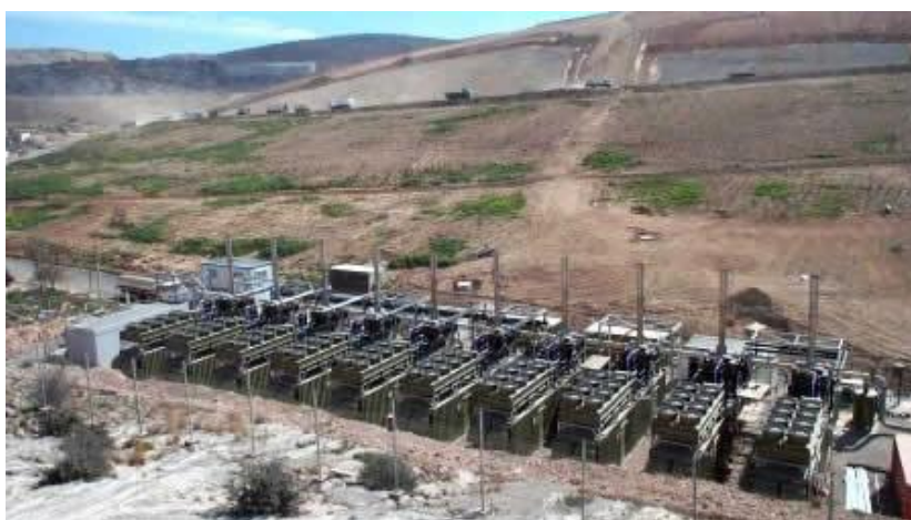
Εικόνα 16 Ηλεκτροπαραγωγά ζεύγη σε ΧΥΤΑ
