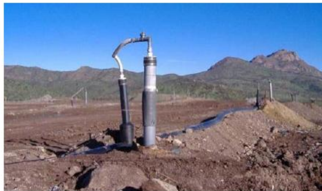
Εικόνα 13 Φρεάτιο εξαερίωσης
