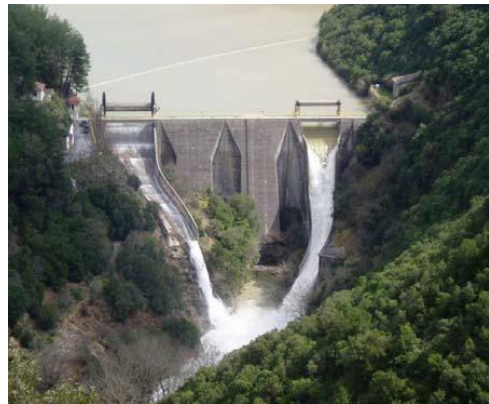
Εικόνα 3.5 Αντηριδωτό φράγμα (Λάδωνας ποταμός, Αρκαδία)
