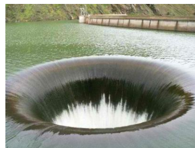
Εικόνα 1.3 Σιφωνοειδής υπερχειλιστής σε λειτουργία (φράγμα Μοντισέλο, Βορεια Καλιφόρνια)
