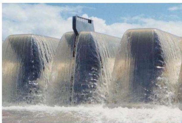
Εικόνα 2.4 Υπερχείλιση fusegates με τη στάθμη του νερού κάτω από τη στέψη του χείλους της χοάνης
