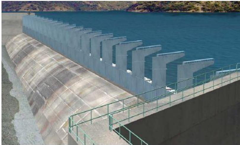
Εικόνα 3.6 Ψηφιακή αναπαράσταση του συστήματος fusegates στη στέψη του υπερχειλιστή στο φράγμα Καστρακίου (πηγή: Ι.Π.Στεφανάκος)
