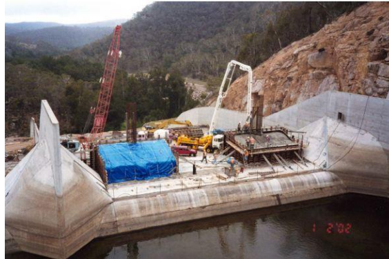
Εικόνα 2.39 Κατασκευή βάσης fusegate από σκυρόδεμα – μονωτικό περίβλημα κατά τη φάση της πήξης
