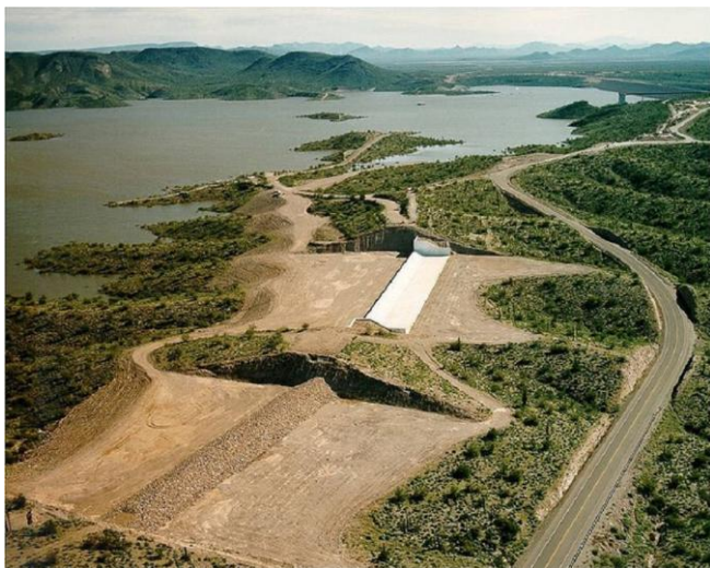
Εικόνα 2.1 Χωμάτινο φράγμα ασφαλείας (fuseplug)
