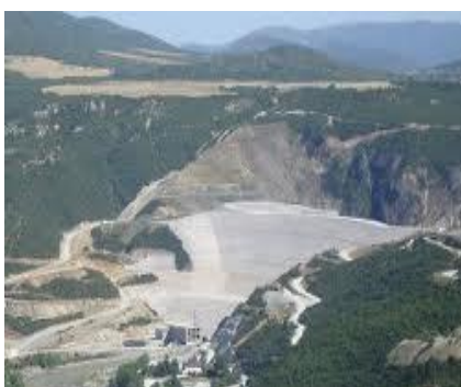
Εικόνα 3.3 Γεώφραγμα (Ιλαρίνας, Αλιάκμονας ποταμός)
