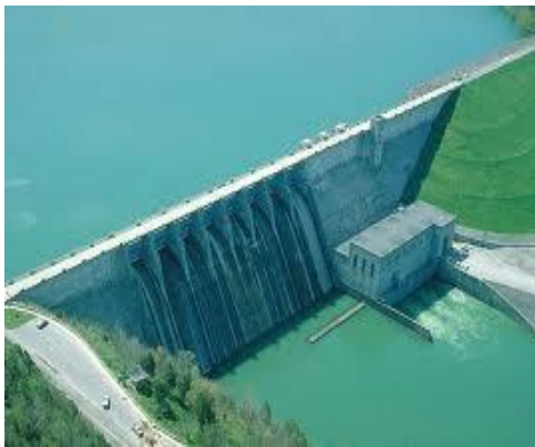
Εικόνα 3.4 Φράγμα βαρύτητας από σκυρόδεμα
