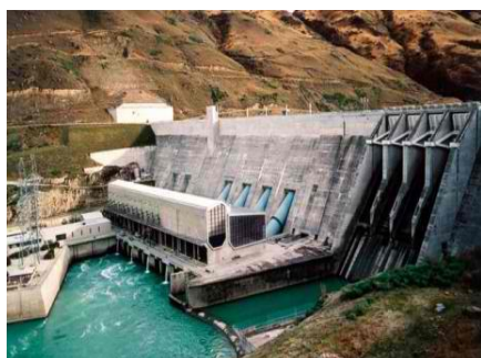
Εικόνα 1.4 Μετωπικός υπερχειλιστής
