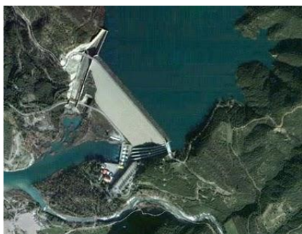
Εικόνα 1.2 Επιφανειακός πλευρικός υπερχειλιστής (φράγμα Καστρακίου)
