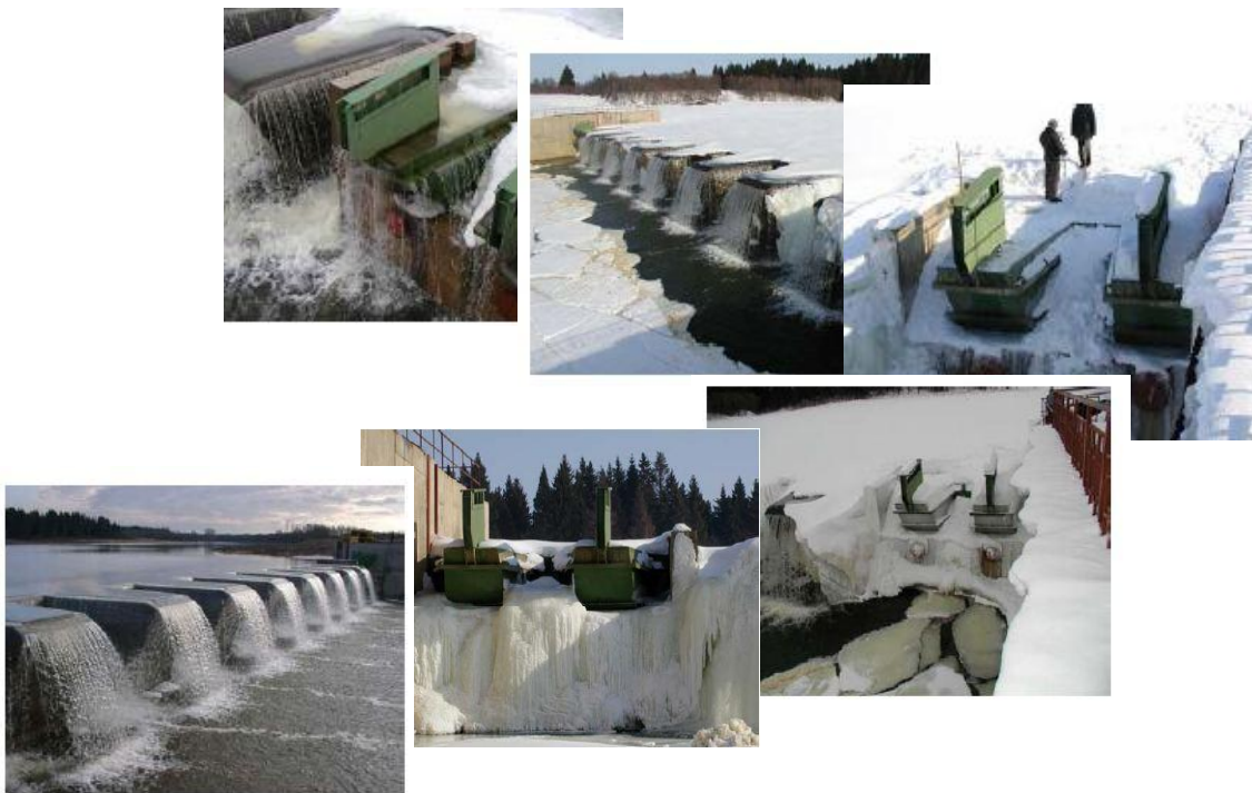
Εικόνες 2.22, 2.23, 2.24, 2.25, 2.26, 2.27 Σύστημα icfusegates στο φράγμα Khorobronskaya (Ρωσία) σε συνθήκες παγετού
