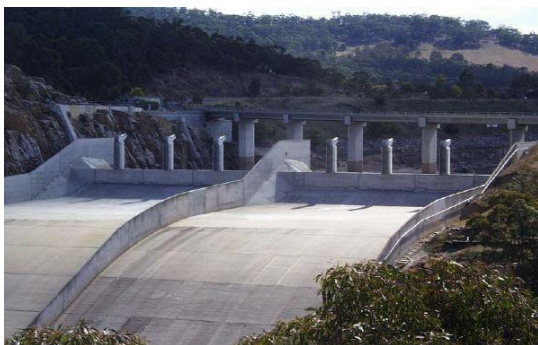
Εικόνα 2.36 Fusegates ευθύγραμμης στέψης από σκυρόδεμα (φράγμα Lyell, Αυστραλία)
