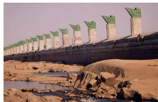
Εικόνα 2.42 Fusegates με μεταλλική χοάνη
