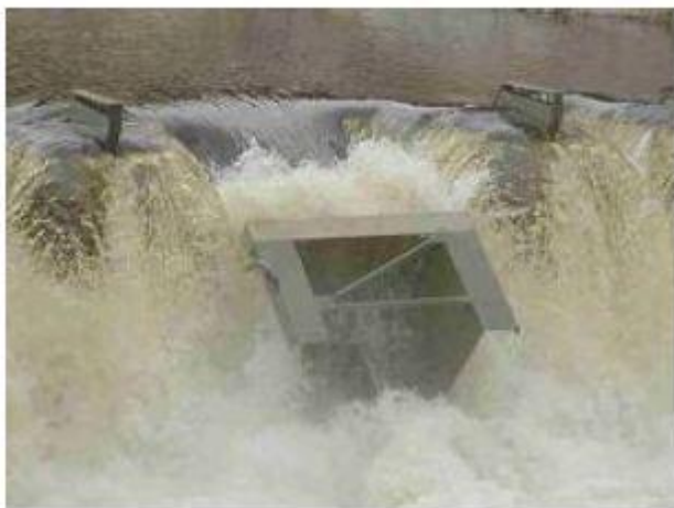
Εικόνα 2.6 Ανατροπή θυροφράγματος
