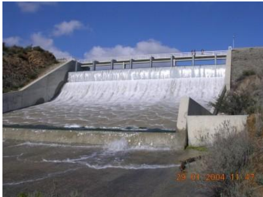
Εικόνα 5.3 Εγκατάσταση fusegates σε υπερχειλιστή φράγματος για την αύξηση της χωρητικότητας του ταμιευτήρα (Δυπόταμος, Κύπρος)
