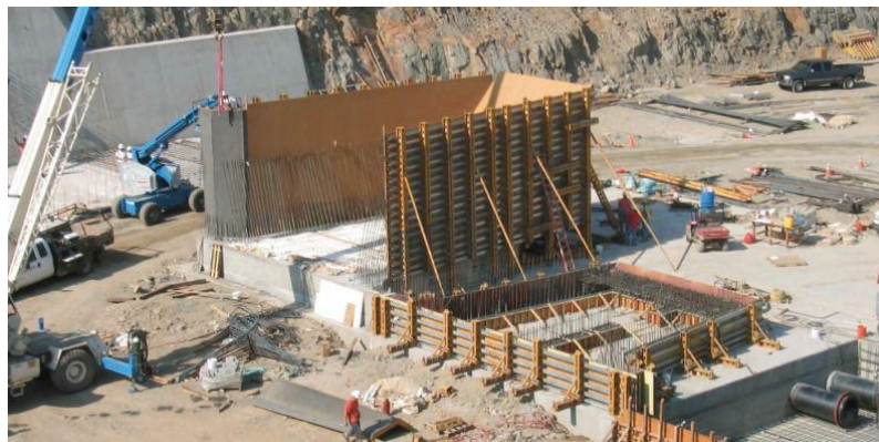
Εικόνα 2.40 Κατασκευή στεγανού θαλάμου βάσης από σκυρόδεμα - καλούπωμα
