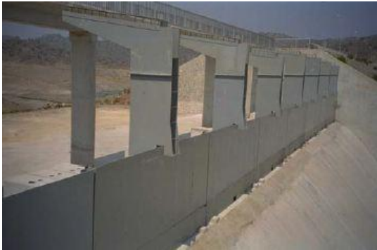
Εικόνα 2.33 Διάταξη θυροφραγμάτων ευθύγραμμης στέψης στο φράγμα του Δυποτάμου (Κύπρος)
