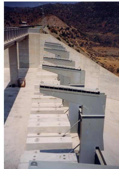
Εικόνα 2.34 Διάταξη fusegates από χάλυβα (Δυπόταμος, Κύπρος)
