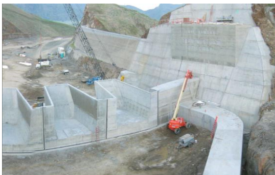
Εικόνα 2.37 Fusegates λαβυρινθοειδούς στέψης από σκυρόδεμα
