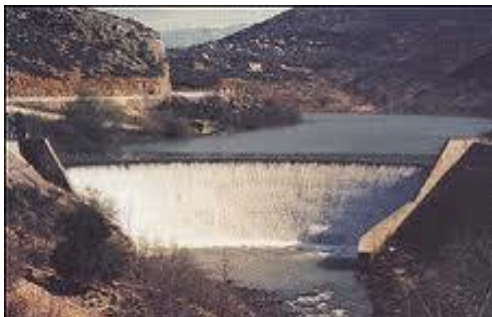
Εικόνα 4.7 Το φράγμα λειτουργεί συνεχώς σε συνθήκες υπερχείλισης, χωρίς δυνατότητα αποθήκευσης
