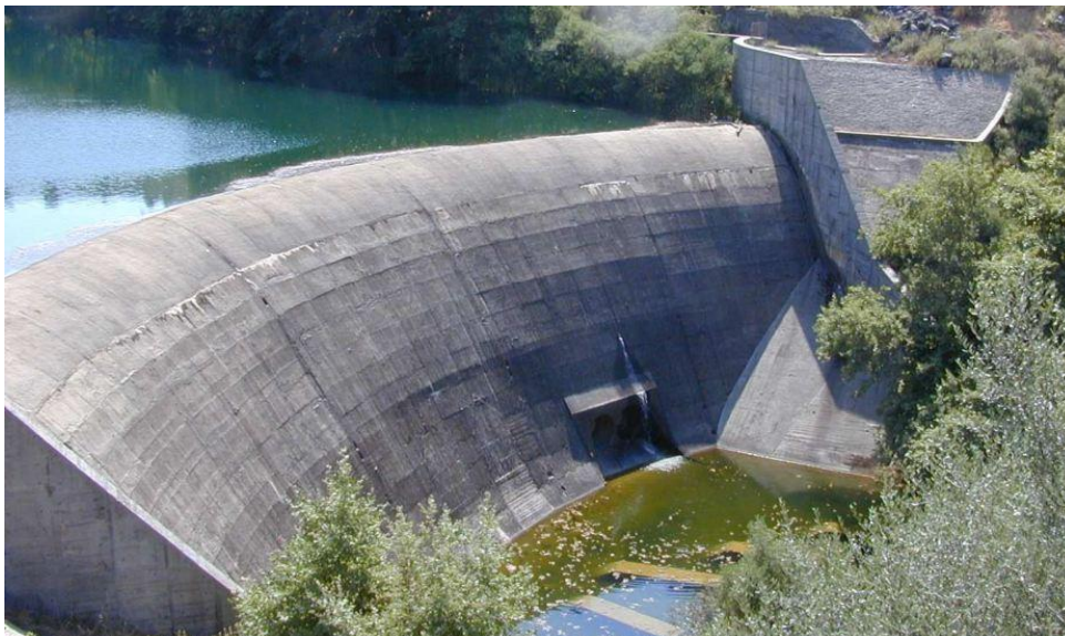
Εικόνα 5.4 Το φράγμα του Λούρου. Ο υπερχειλιστής καταλαμβάνει το μεγαλύτερο τμήμα του φράγματος (77m μήκος έναντι 97m συνολικού μήκους φράγματος).
