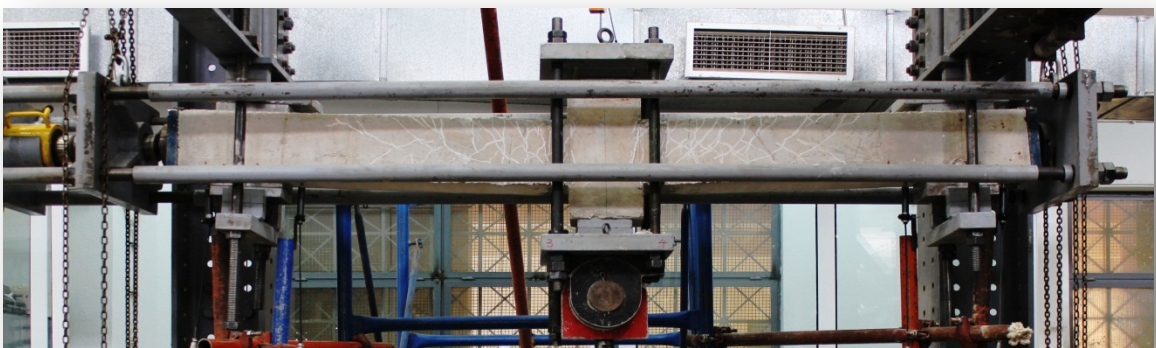
ΕΙΚΟΝΑ 4.10 Ρηγματωμένη κατάσταση του φορέα μετά την διαρροή.
