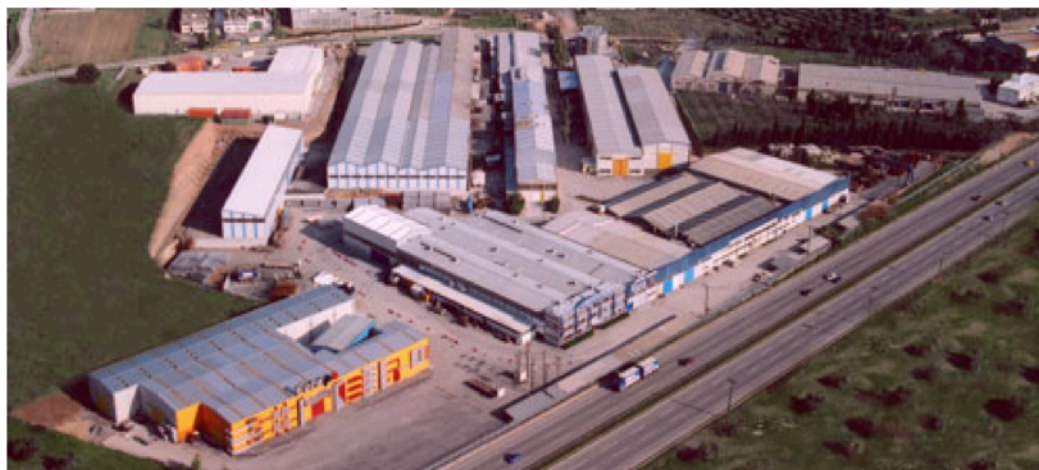
Άποψη του συνόλου των εγκαταστάσεων του Ομίλου.
