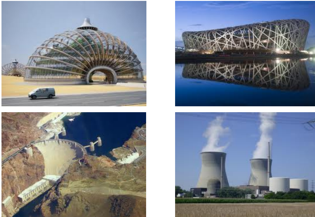
Εικόνα 1.3 Παραδείγματα κελυφωτών κατασκευών
