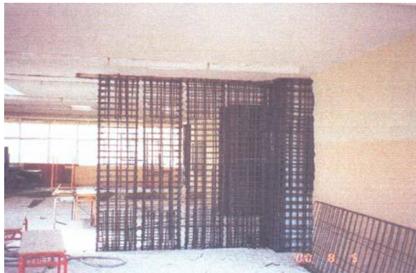
Εικόνα 10 Προσθήκη πολυμελών τοιχωμάτων
