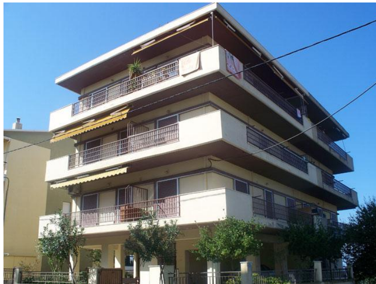
Εικόνα 1 Κτίριο με πυλωτή το ισόγειο
