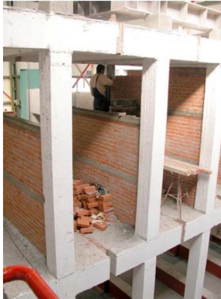
Εικόνα 4 Τα διώροφα πλαίσια του πειράματος κατά τη φάση κατασκευής τους
