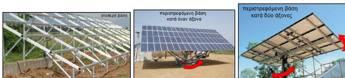
Εικόνα 6: Βάσεις στήριξης φωτοβολταϊκών συστημάτων
