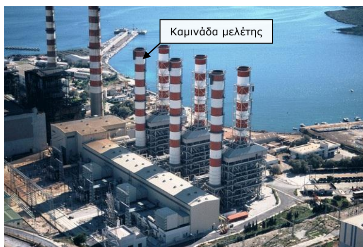
Σχήμα 4.3: Παρακαμπτήριοι καμινάδα Μονάδας IV
