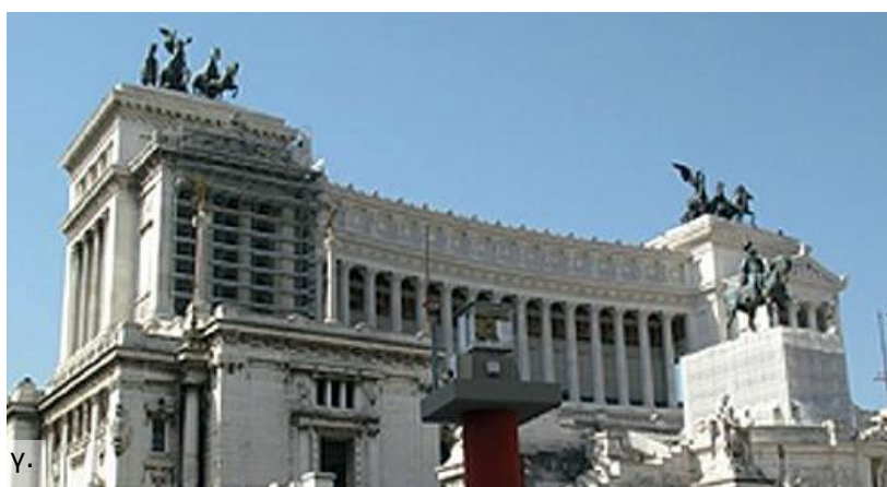
Σχήμα 2.16: Εικόνες από την εγκατάσταση Ολοκληρωμένου Συστήματος Παρακολούθησης για την κατασκευή της γραμμής Γ του υπογείου σιδηροδρόμου στη Ρώμη. Διακρίνονται η ειδική κατασκευή εγκατάστασης του Ρομποτικού Γεωδαιτικού Σταθμού, ο δέκτης GPS και το ψηφιακό κλισίμετρο ( http://www.imoss.com )
