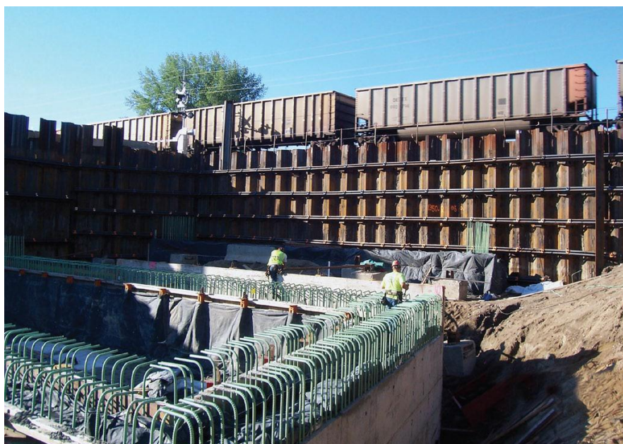
γ. Άποψη μέρους του εργοταξίου
