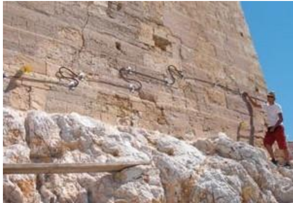
Σχήμα 2.13: Στιγμιότυπο από τοποθέτηση αισθητήρων οπτικής ίνας τύπου FBG στο τείχος της Ακρόπολης στα πλαίσια διερεύνησης της δομικής συμπεριφοράς του Τείχους (Αστρεϊνίδης et al., 2008)
