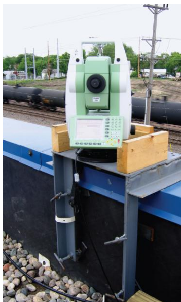
α. Εγκατάσταση του γεωδαιτικού σταθμού σε στηθαίο κτιρίου
