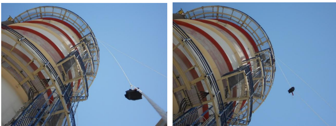
Σχήμα 5.6: Στιγμιότυπα ανύψωσης εξοπλισμού στην καμινάδα
