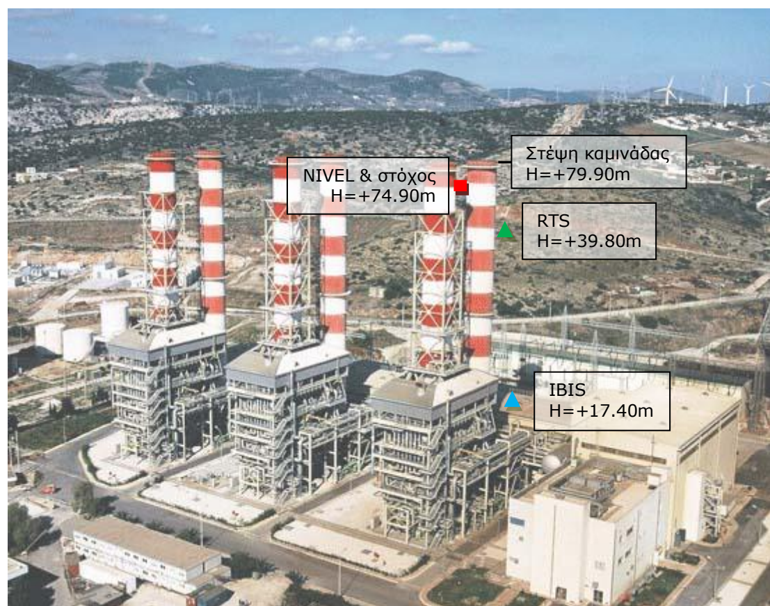
Σχήμα 5.4: Άποψη τελικής θέσης συστημάτων στην περιοχή μελέτης υψομετρικά
