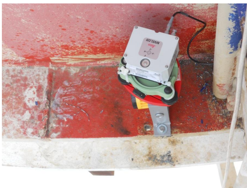
Σχήμα 5.5: Εγκατάσταση συστήματος κλισιμέτρου-στόχου στην καμινάδα
