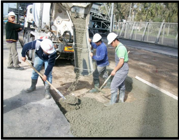
Εικόνα 2.1: Διάστρωση πορώδους σκυροδέματος.
