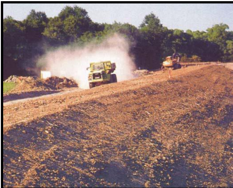
Εικόνα 1.8: Κατασκευή αναχωμάτων ποταμού (πηγή: Early Warning Systems in the Framework of the Cologne Flood Protection Scheme, Stadtentwässerungs-betriebe Köln, AoR ).
