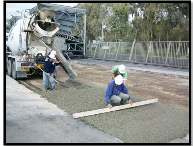
Εικόνα 2.2: Ομαλοποίηση διαστρωμένης επιφάνειας.
