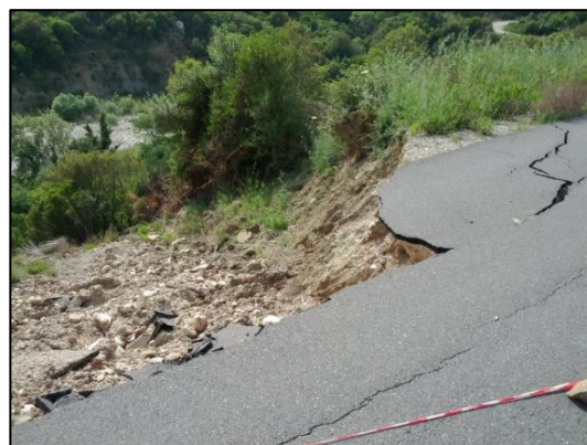
Φωτογραφία 1-3 Διακρίνεται το ρέμα Σελλάς Photo 1-3 Sellas river is visible
