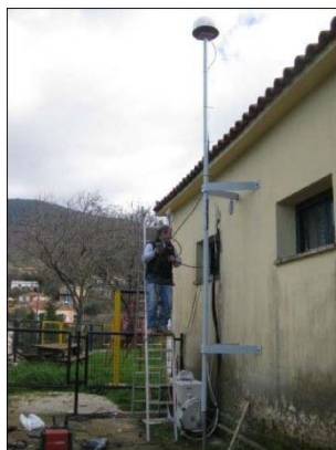
Φωτογραφία 2-2 Η στερέωση της βάσης κεραίας Photo 2-2 Fixation of antenna base
