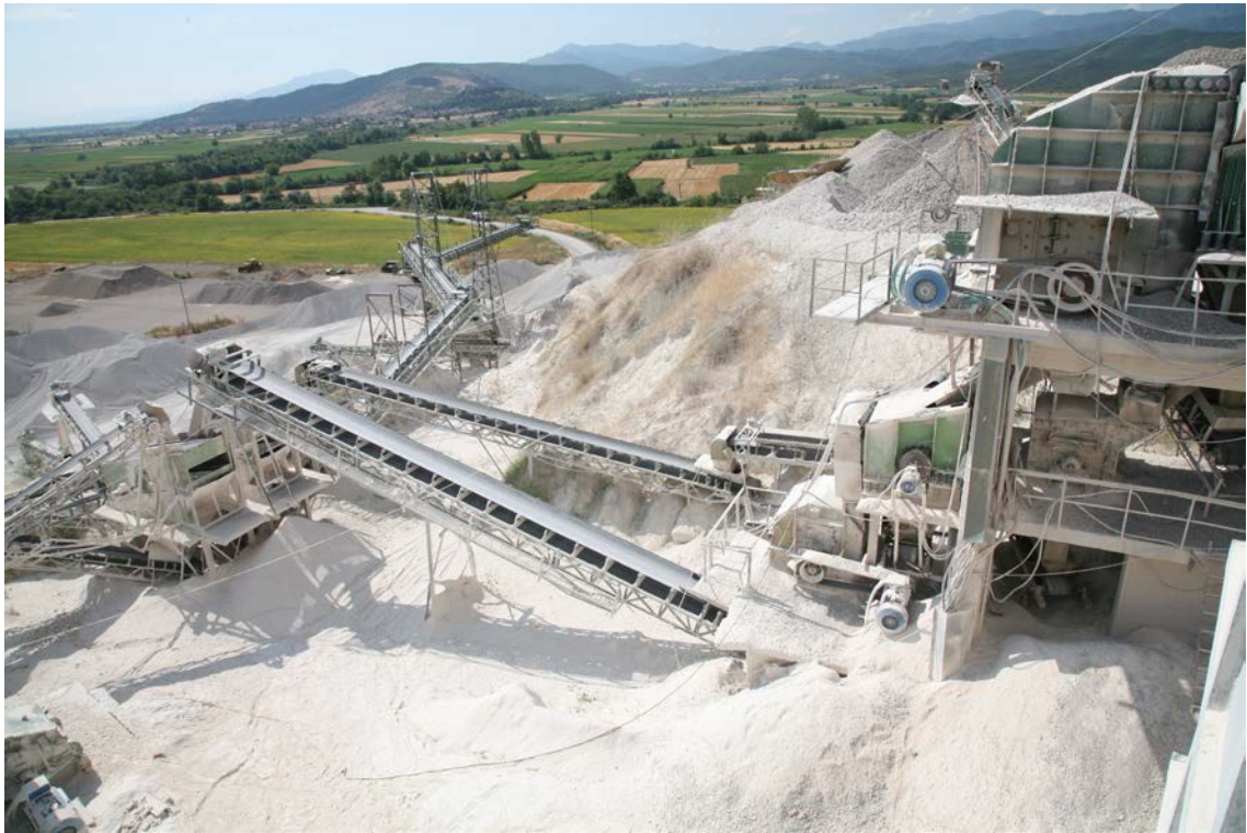
Εικόνα 15. Αποψη του κυκλώματος πρωτογενούς θραύσης του λατομείου αδρανών υλικών.
