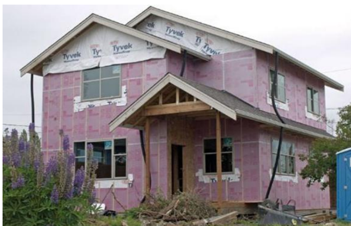
Εικ.4.5.4. Εφαρμογή εξωτερικής θερμομόνωσης [76]
