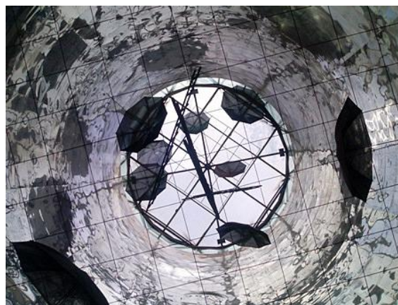
Εικ.4.7.10. Κυλινδρικός φωταγωγός [57]
