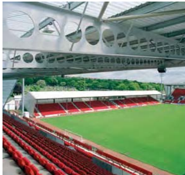
Εικόνα 2.7: Στέγαστρο γηπέδου στο Dunfermline, Fife, Scotland που αποτελείται από συστήματα προβολών 21 μέτρων
