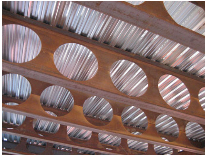
Εικόνα 2.8: Νοτιοδυτικό κτήριο του πανεπιστημίου της Columbia, δοκοί ύψους 5 πόδια γεφυρώνουν άνοιγμα 40 πόδια
