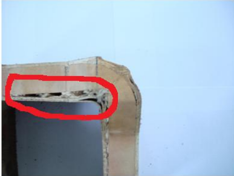
Εικόνα 7.11α Απεικόνιση σφαλμάτων της δομής του δοκιμίου στη γωνία του δοκιμίου S02(κάτοψη)
