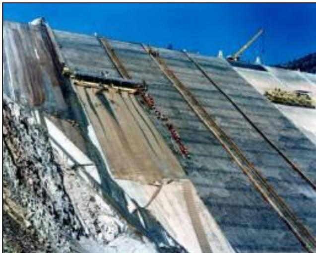
Εικόνα 5. Λιθόρριπτο φράγμα με επένδυση από σκυρόδεμα, Ραμπεντώσα
