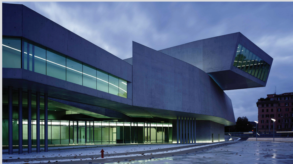
Εξωτερική άποψη της εισόδου του MAXXI
