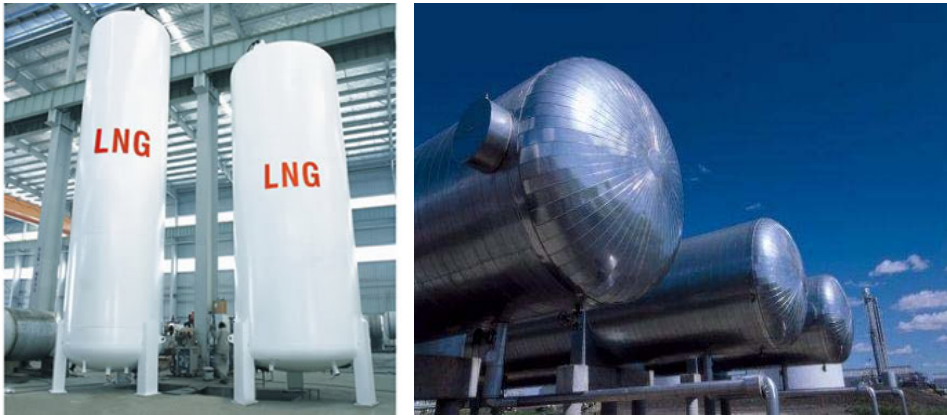
Εικόνες 1.35 (αριστερά) και 1.36 (δεξιά): Δεξαμενές αποθήκευσης LNG
