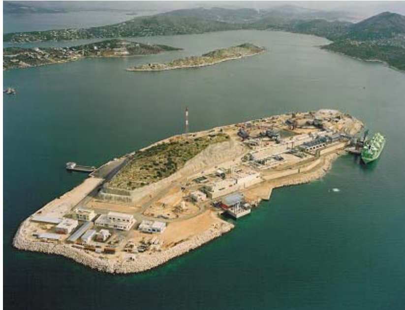
Εικόνα 3.5: Σταθμός Υγροποιημένου Φυσικού Αερίου στη νήσο Ρεβυθούσα
