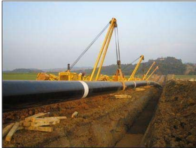
Εικόνα 3.1: Τοποθέτηση αγωγού Υψηλής Πίεσης
