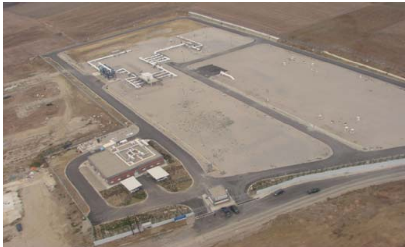
Εικόνα 3.3: Μεθοριακός σταθμός Κήπων, μέτρηση και ρύθμιση ροής
