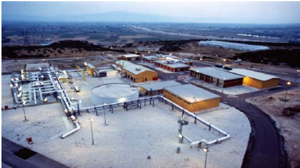
Εικόνα 3.2: Μεθοριακός σταθμός Σιδηροκάστρου, μέτρηση και ρύθμιση ροής αερίου
