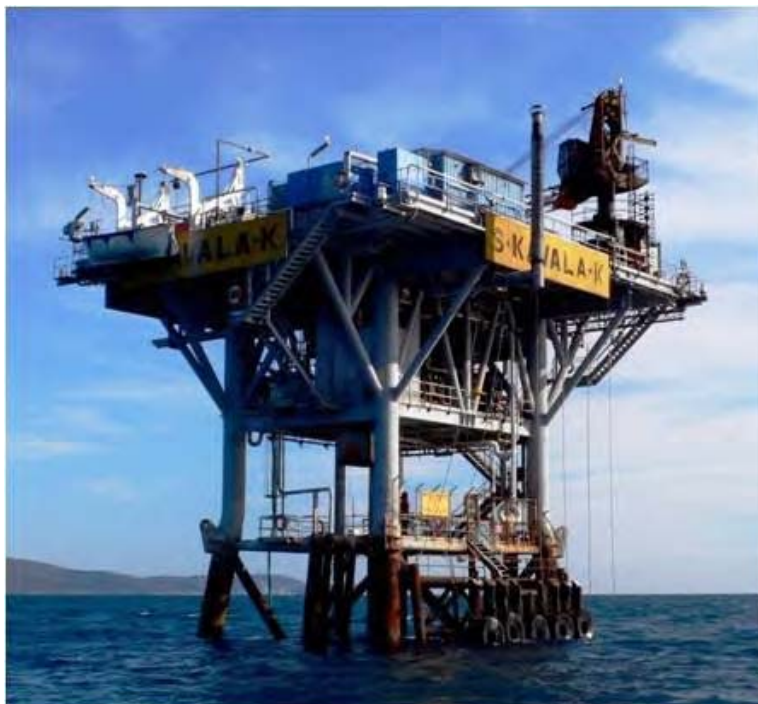
Εικόνα 6.6: Εξέδρα «Κάππα» του κοιτάσματος «Νότια Καβάλα»
