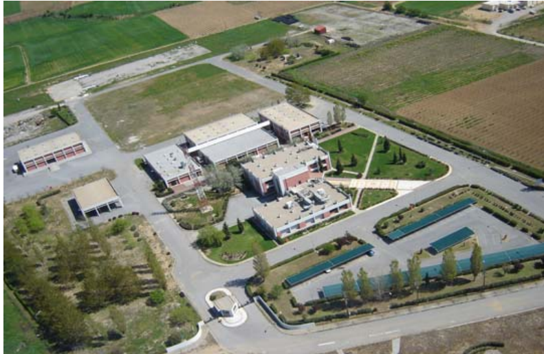
Εικόνα 3.4: Κέντρο Λειτουργίας και Συντήρησης
