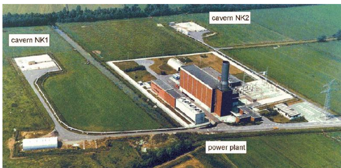
Σχήμα 3.22 : Αεροφωτογραφία μονάδας CAES στο Huntorf
