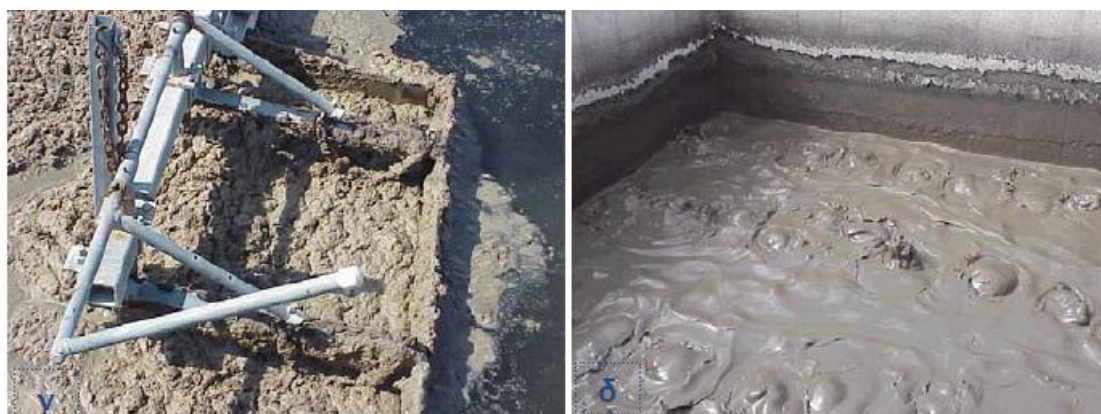
Εικόνα 2.5 Νηματοειδής αφρός (γ) στη δεξαμενή τελικής καθίζησης και (δ) στο φρεάτιο συλλογής ιλύος (Πηγή : Μαρνέρη, 2010)
