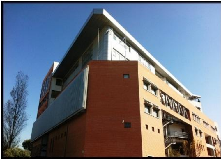
Εικ. 4.12: Το κτήριο της Ε.Σ.Υ. στον Πειραιά
