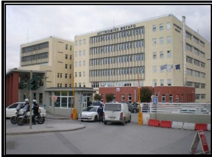
Εικ. 4.14: Το κτήριο του Αρχηγείου στον Εύοσμο
