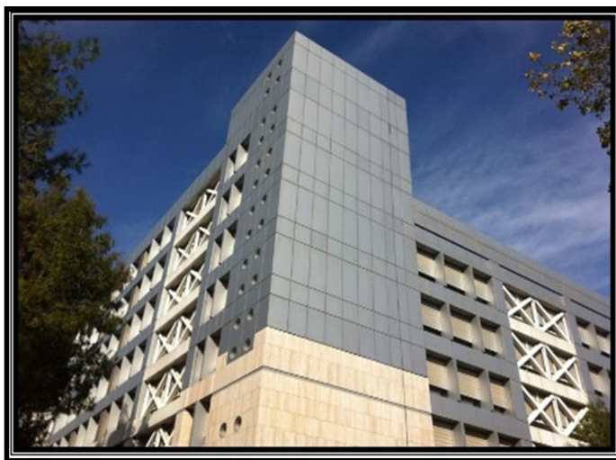
Εικ. 4.10: Το κτήριο του Υπ. Πολιτισμού στον Ρέντη
