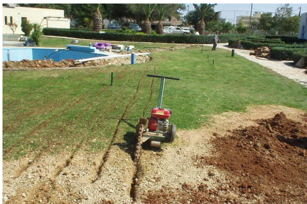
Σχήμα 5.4 Υπόγεια στάγδην άρδευση
