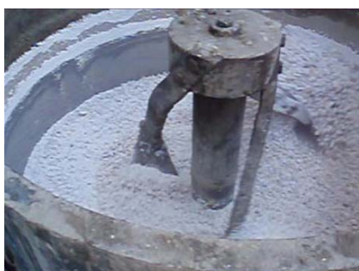
Εικόνα 14: Ανάμιξη ομογενοποιημένων γαρμπιλιού αδρανών με φύλλερ
