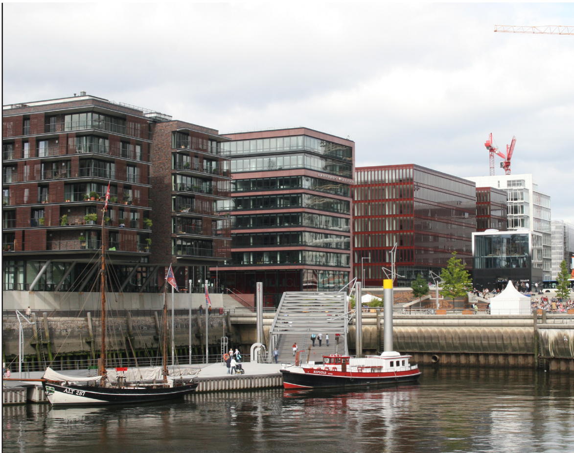
Εικ. 3. Κτήρια γραφείων και κατοικιών στην Hafencity στο Αμβούργο, δείγμα λιμενικής ανάπλασης επηρεασμένης από την μεταμοντέρνα κουλτούρα. Πηγή: www.wikipedia.org
