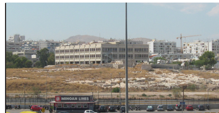
Εικ. 9. Κτίριο του ΟΛΠ στο Καστράκι Πηγή: προσωπικό αρχείο
